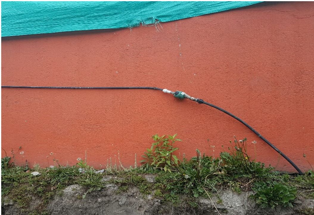
Foto 1. Medidor expuesto por demolición existente 1/2"
