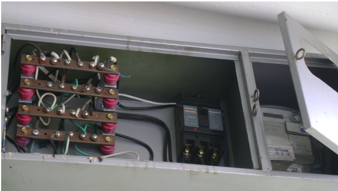
IMAGEN 1 TABLERO PRINCIPAL. TRIFÁSICO UBICACIÓN MURO ENTRADA PRINCIPAL.
