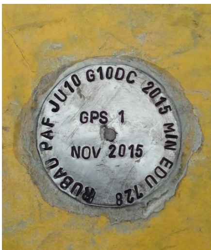
Fotografías 1.1 Instalación de referencias de georeferenciación
