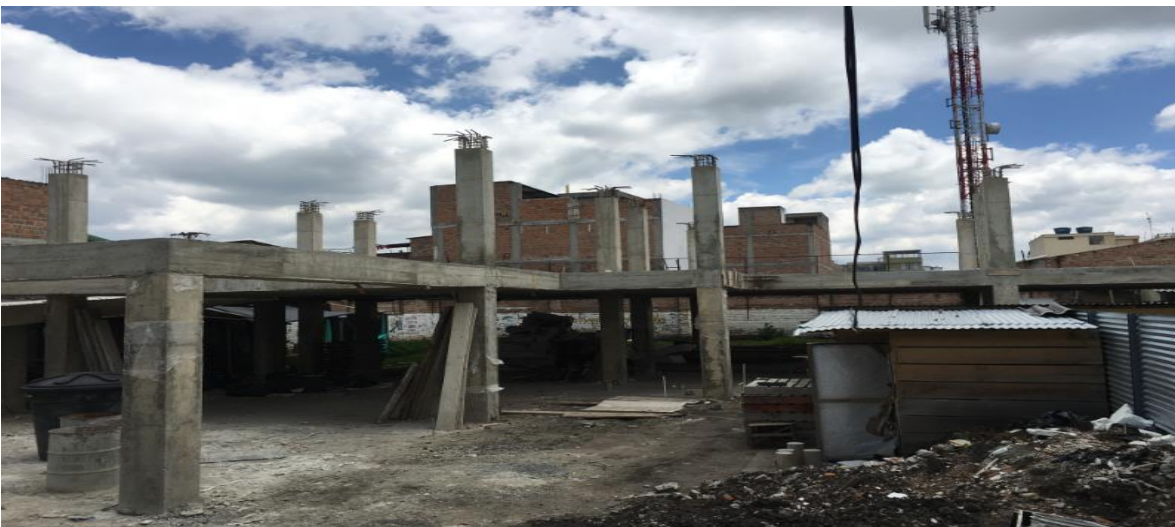
PANORAMICA ESTADO ACTUAL OBRA
