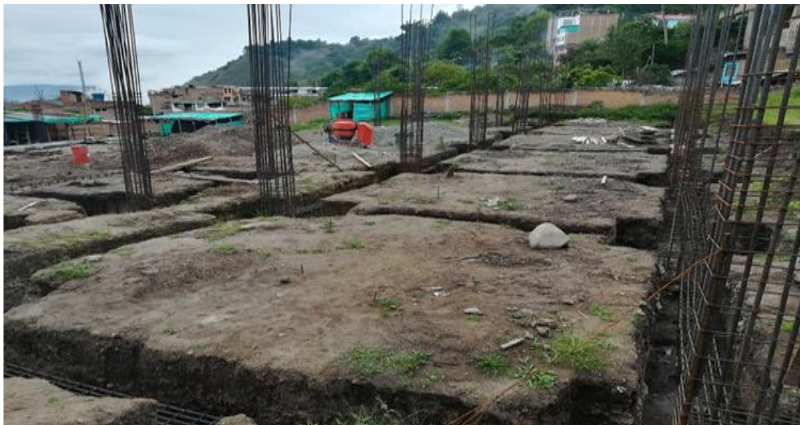
PANORAMICA ESTADO ACTUAL OBRA
