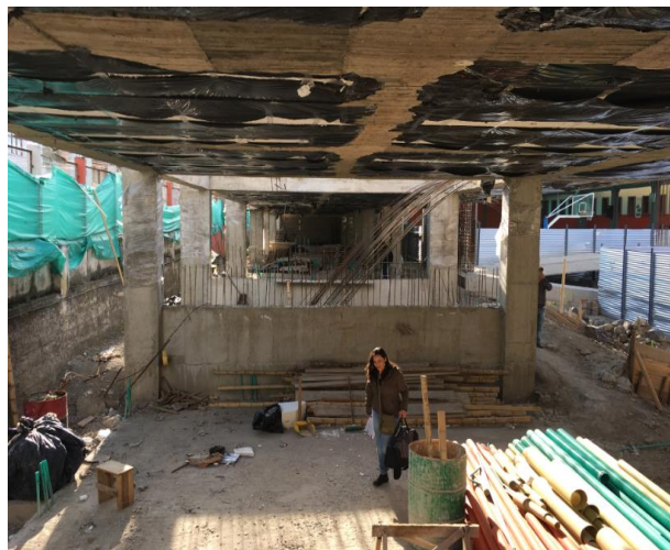
ESTADO ACTUAL OBRA
