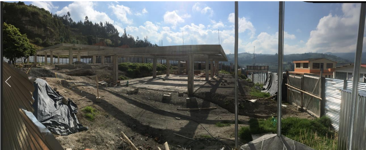
PANORAMICA ESTADO ACTUAL OBRA
