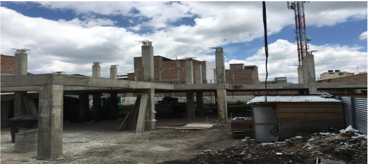
PANORAMICA ESTADO ACTUAL OBRA
