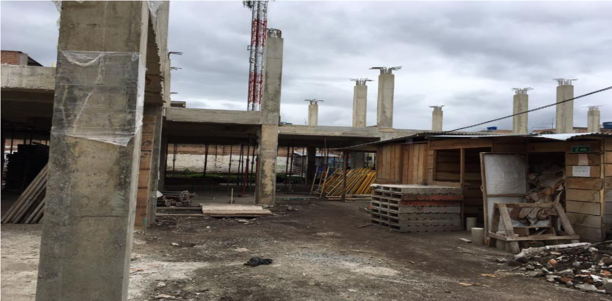
PANORAMICA ESTADO ACTUAL OBRA
