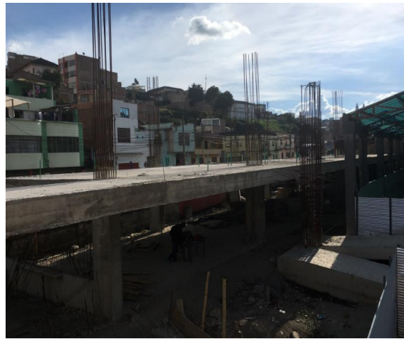
ESTADO ACTUAL OBRA
