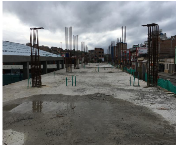
ESTADO ACTUAL OBRA
