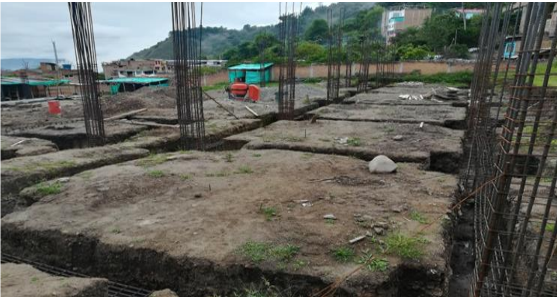
PANORAMICA ESTADO ACTUAL OBRA
