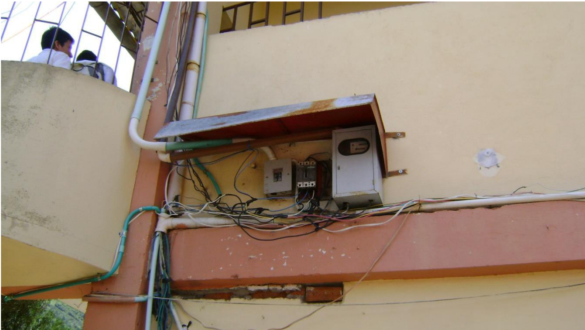
EQUIPO DE MEDIDA-TOTALIZADOR-TABLERO DOS CIRCUITOS.
