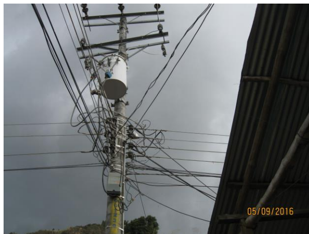
Fig. No 1.1.2 Conexión de Transformador.
