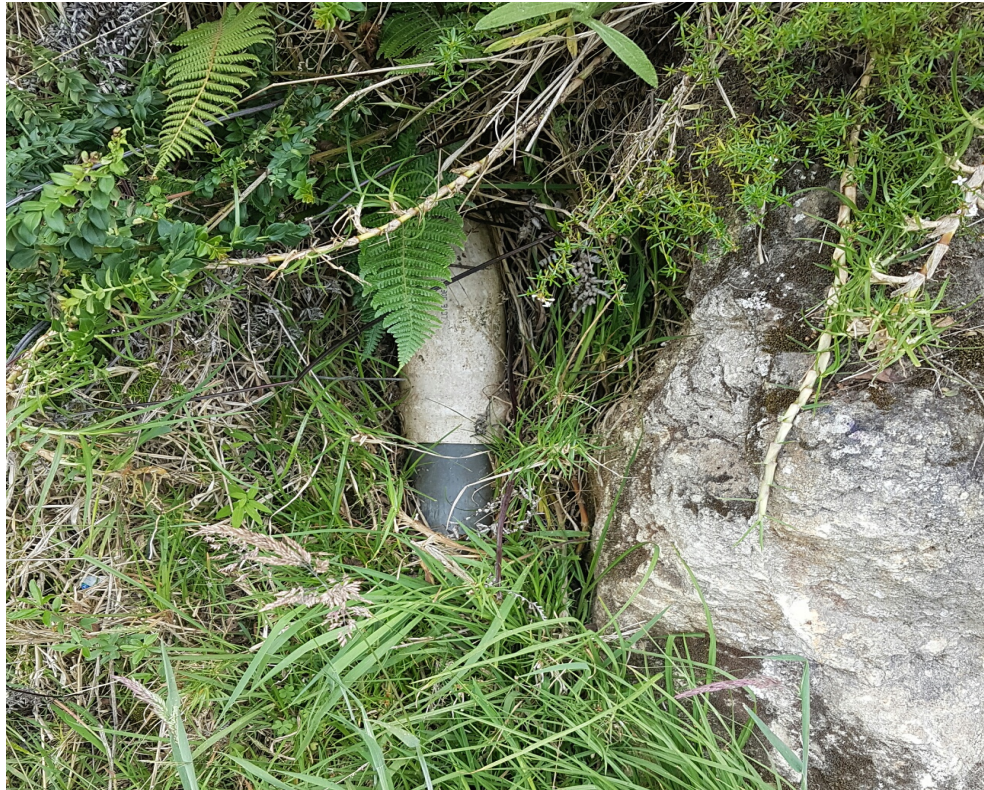
Foto 2. Llegada acometida agua potable en 2" sin medidor
