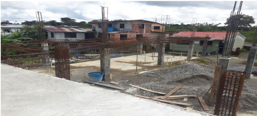
PANORAMICA ESTADO ACTUAL OBRA
