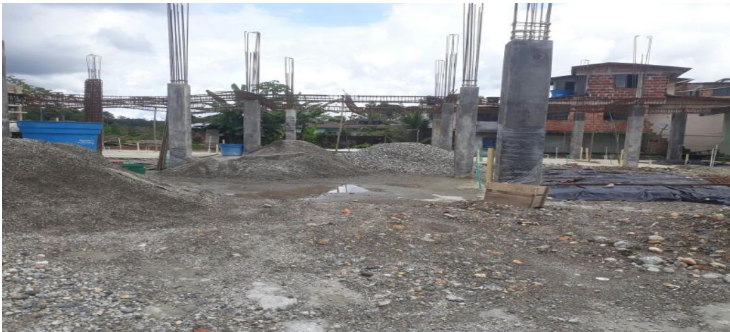
PANORAMICA ESTADO ACTUAL OBRA
