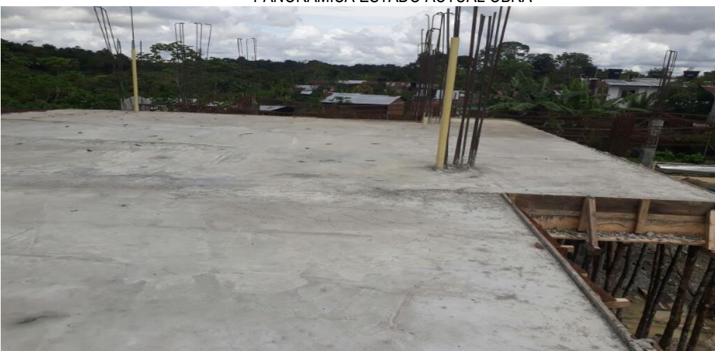
PANORAMICA ESTADO ACTUAL OBRA
