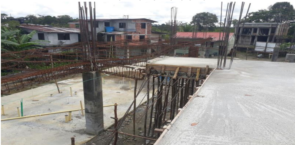
PANORAMICA ESTADO ACTUAL OBRA
