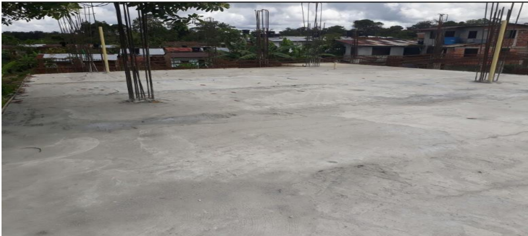
PANORAMICA ESTADO ACTUAL OBRA
