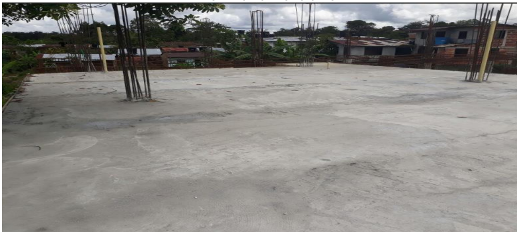
PANORAMICA ESTADO ACTUAL OBRA
