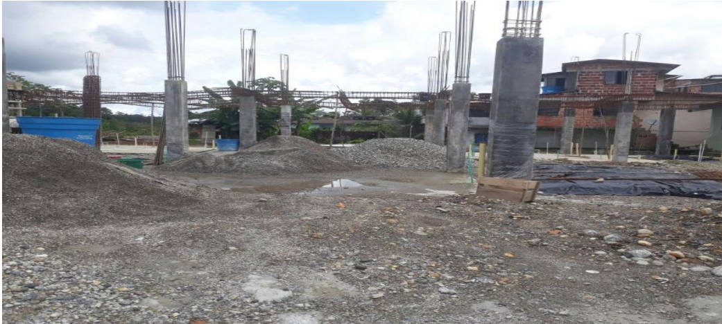
PANORAMICA ESTADO ACTUAL OBRA
