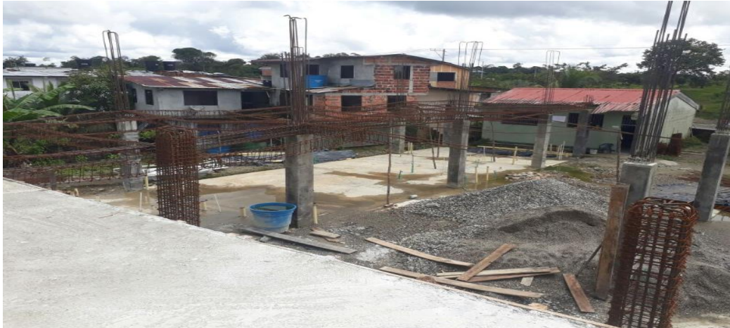
PANORAMICA ESTADO ACTUAL OBRA
