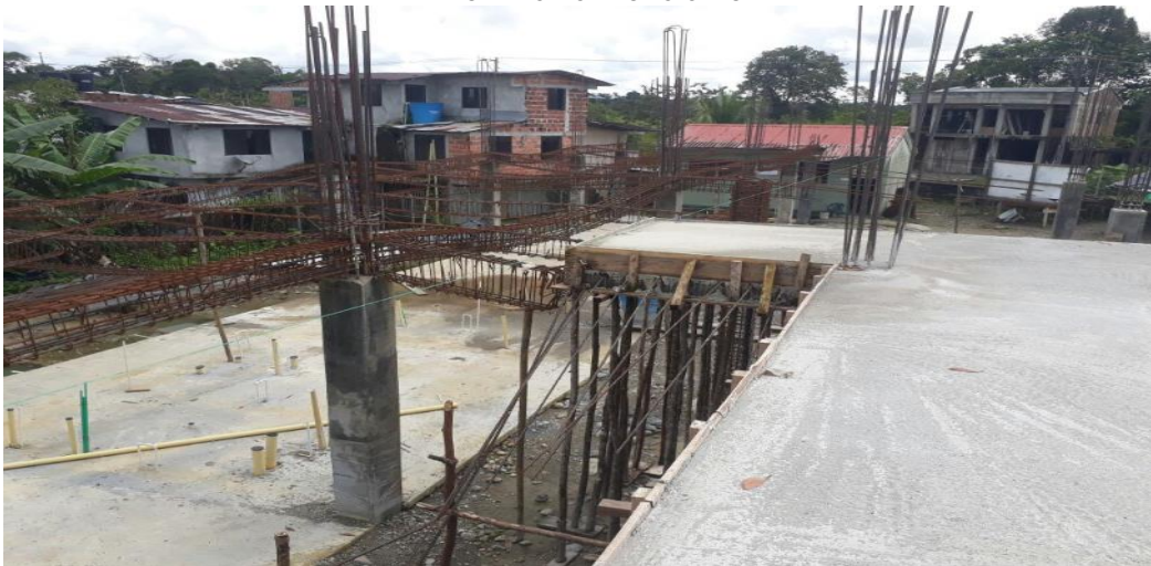
PANORAMICA ESTADO ACTUAL OBRA
