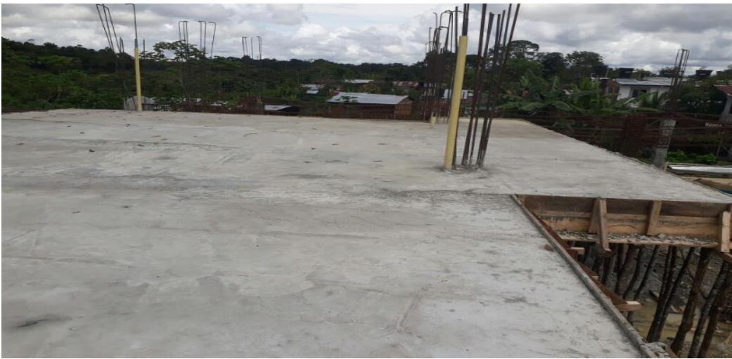
PANORAMICA ESTADO ACTUAL OBRA
