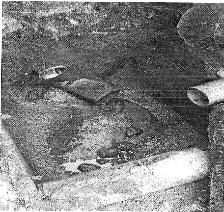
Foto 2. Caja de aguas negras existente.
