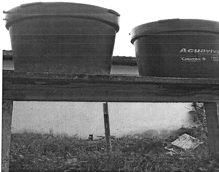
Foto 1. Tanques plásticos elevados recolectores de aguas lluvia
