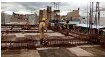
Foto 6. Instalación acero vigas aéreas
