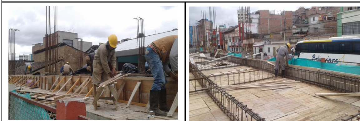
Foto 14 - 15: Instalación de tableros.
