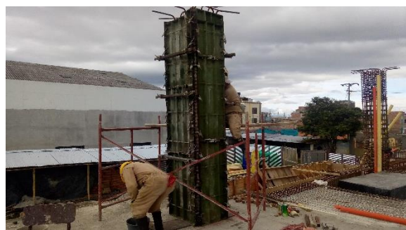
FOTO 6. FUNDICIÓN DE COLUMNAS 2 DO NIVEL - esta actividad se realiza sin contratiempos
