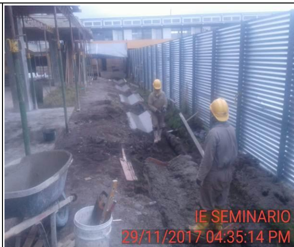
FOTO 5: Continúa fundición concreto cuneta perimetral.
