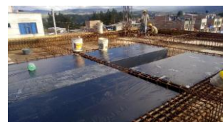
Foto 10. Instalación Casetones De Icopor
