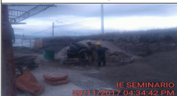
FOTO 6: Mezcla de concreto para canal
