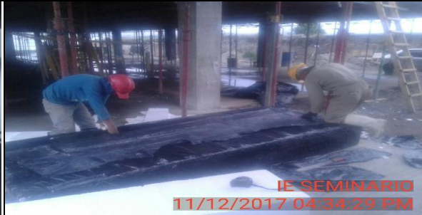
FOTO 3: Modulador de icopor para tramo de losa de entrepiso nivel 1.
