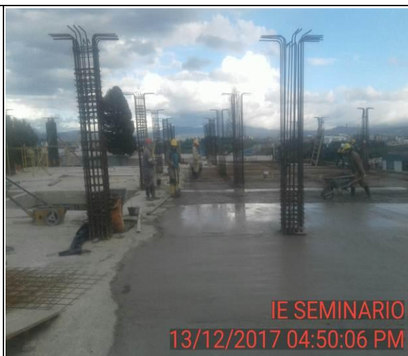
FOTO 39: Fundición concreto de 3000 psi mezclado en obra de 3er tramo losa nivel 1.
