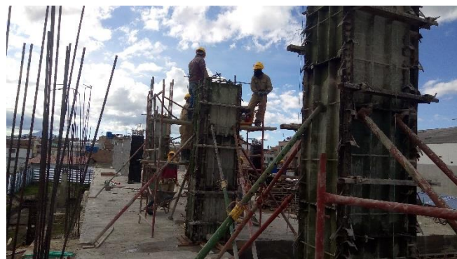
FOTO 18 FUNDICIÓN DE COLUMNAS 2 DO NIVEL - esta actividad se realiza sin contratiempos
