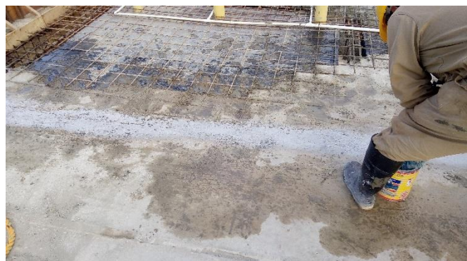
FOTO 12. APLICACIÓN DE ADITIVO EN JUNTA - esta actividad se realiza sin contratiempos
