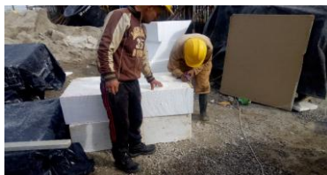
Foto 8. Instalación Casetones De Icopor
