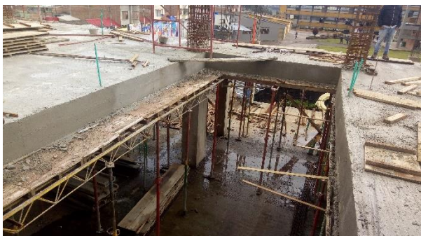
FOTO 29. RETIRO DE FORMALETA DE LOSA- esta actividad se realiza sin contratiempos
