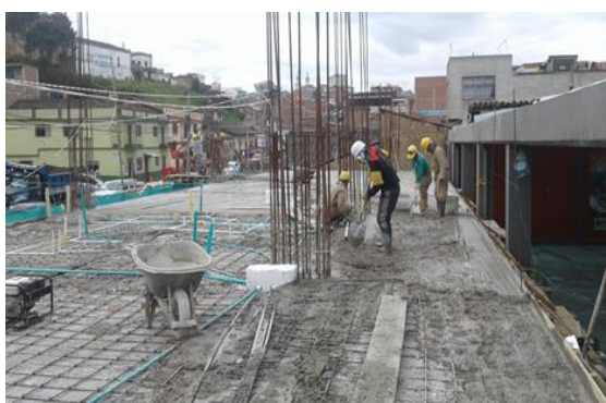
Foto 20 -21 : Fundida de losa .
