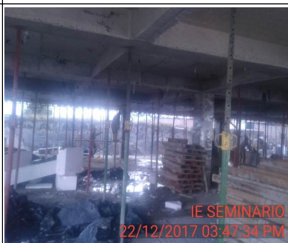
FOTO 52: Desencofrado de 4to tramo de los de entepiso nivel 1.
