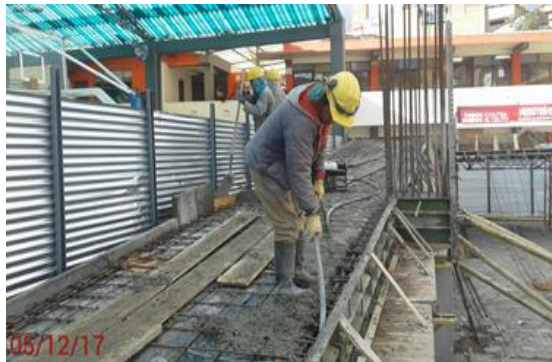
Foto 6-7: Fundición de rampa.
