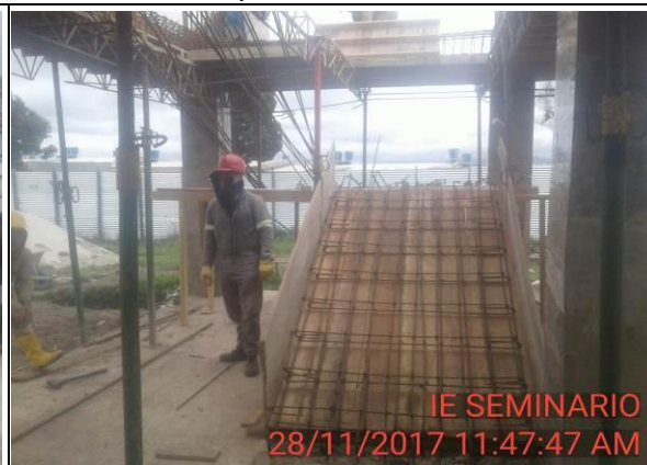
FOTO 3: Continúa formaleta de escalera e instalación de acero.
