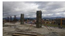
Foto 13. Fundición de Columnas 3000 psi.
