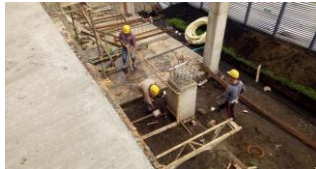
Foto 2. Instalación acero columnas
