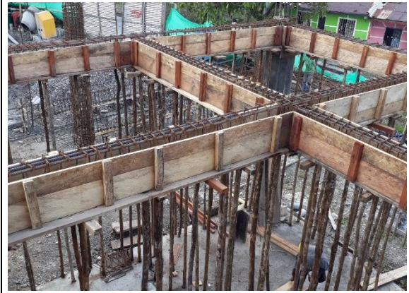
FOTO 6: formaleta en madera para vigas aéreas.
