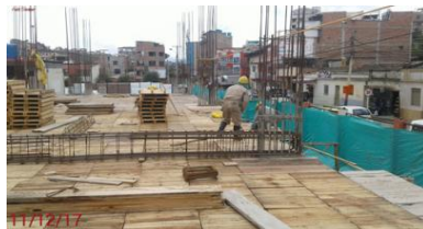
Foto 1-2-3: Armado de aceros para vigas aéreas
