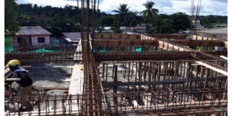
ARMADO DE VOLADIZOS
