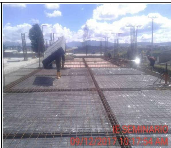
FOTO 28: Instalación de módulos de icopor, para losa de entepiso nivel 1.
