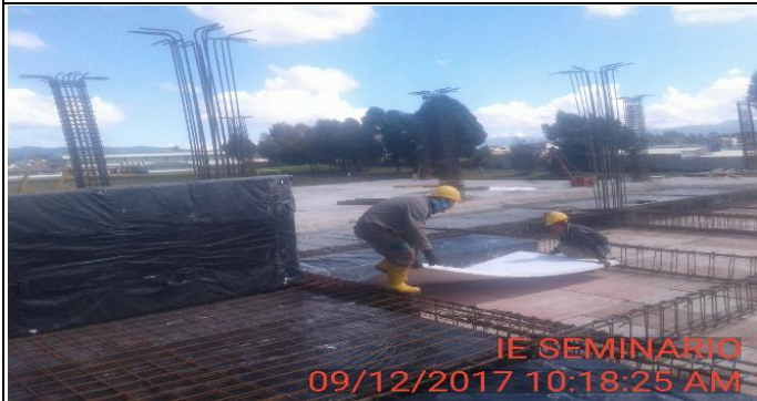
FOTO 14: Inicia instalacion de modulos de icopor para ultimo tramo de losa de entrepiso nivel 1.
