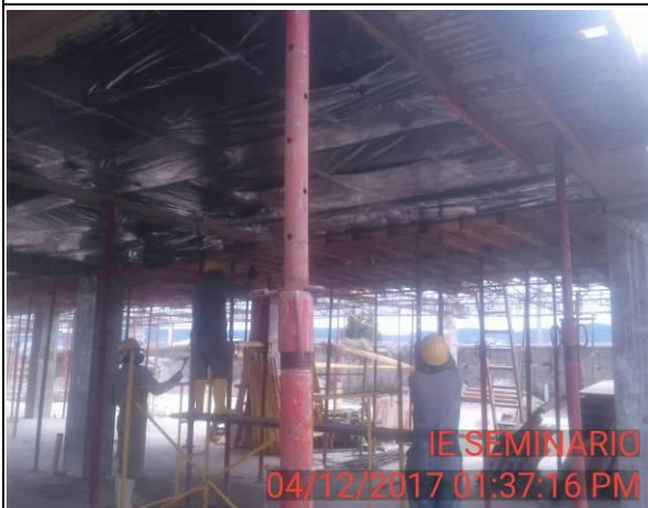
FOTO 17: Desmonte tramo de formaleta fundida, para losa de entrepiso nivel 1.
