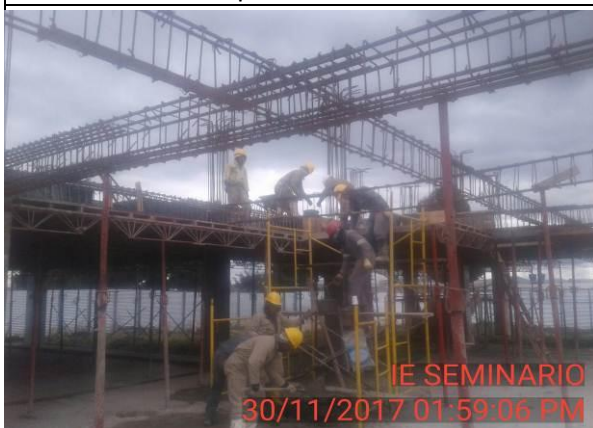
FOTO 8: Transporte vertical de concreto por medio de baldes para tramo pequeño de losa.
