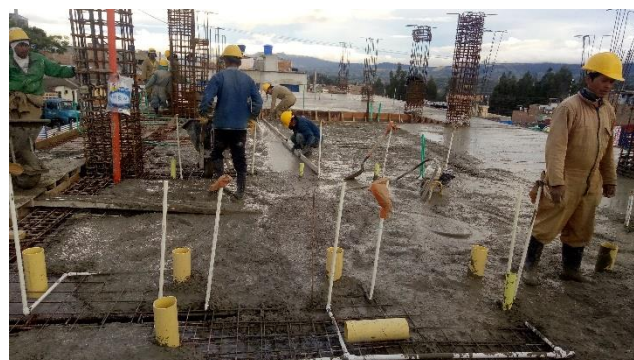
FOTO 14. FUNDICIÓN DE LOSA DE ENTREPISO CCTO 3000 psi - esta actividad se realiza sin contratiempos
