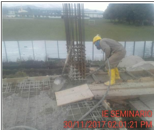
FOTO 10: Fundición de concreto de 3000 psi para losa de entrepiso nivel 1, tramo pequeño.
