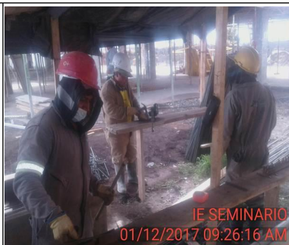
FOTO 11: Figurado de acero para estribos columnas nivel 2.
