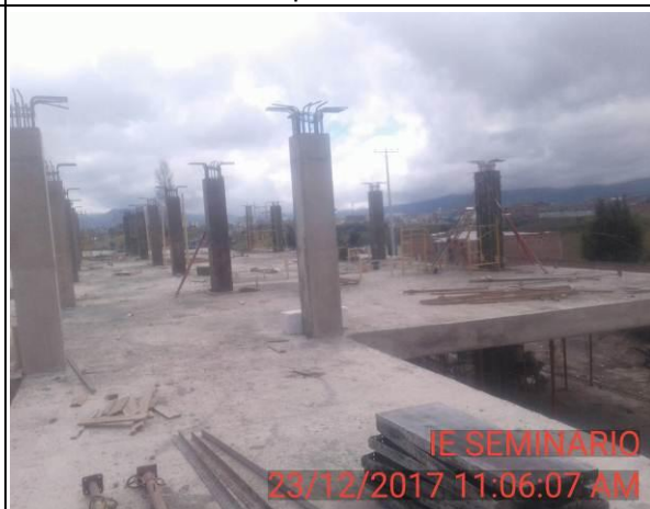
FOTO 54: Vista general ejes 3 y 4.
