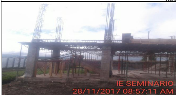
FOTO 2: Se observa al fondo el armado de acero de escalera.
