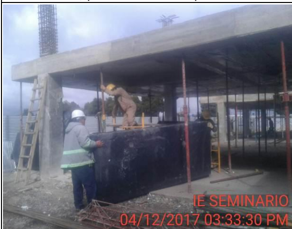
FOTO 19: Desmonte tramo de formaleta fundida, para losa de entrepiso nivel 1.
