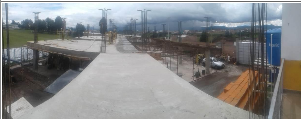
FOTO 1: Vista panorámica se observa el 55% de la losa de entrepiso nivel 1 fundida, el otro tramo sin formaleta, también se observa estribos para columnas nivel 2.
