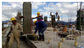
Foto 12. Fundición de Columnas 2do piso
