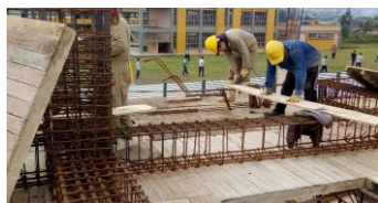
Foto 5. Instalación acero vigas aéreas
