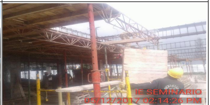
FOTO 7: Inicia instalacion de formaleta para siguiente tramo de losa de entrepiso nivel 1, con la misma formaleta del tramo que se habia fundido hace 10 dias.
