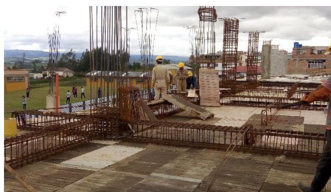
FOTO 8. INSTALACIÓN DE ACERO DE VIGAS AÉREAS - esta actividad se realiza sin contratiempos
