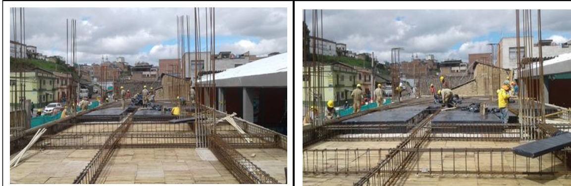
Foto 12- 13: Instalación de icopor para losa de primer piso.
