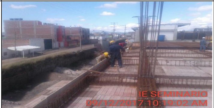
FOTO 15: Instalacion de formaleta lateral para losa de entrepiso nivel 1.
