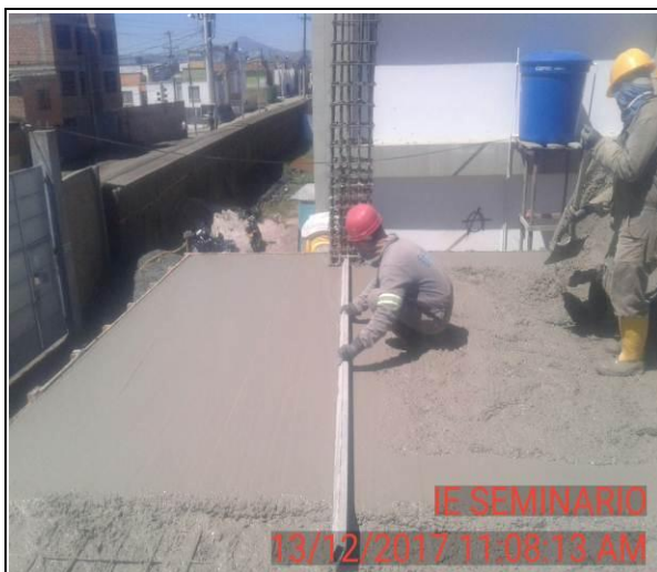
FOTO 38: Fundición concreto de 3000 psi mezclado en obra de 3er tramo losa nivel 1.
