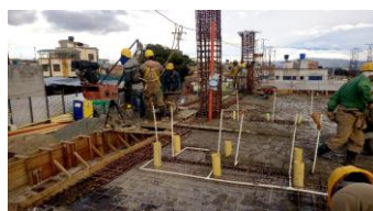
Foto 14. Fundición de Losa de Entrepiso
