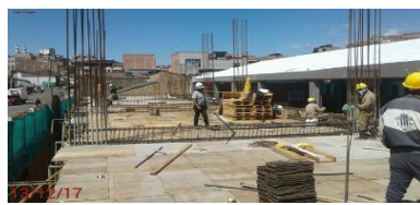
Foto 4-5-6: Armado de aceros para vigas aéreas.
