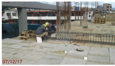
Foto 1-2-3: Armado de aceros para vigas aéreas.
