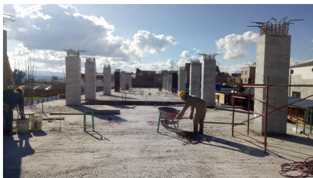
FOTO 27. FUNDICIÓN DE LOSA DE ENTREPISO – se realiza sin contratiempos.
