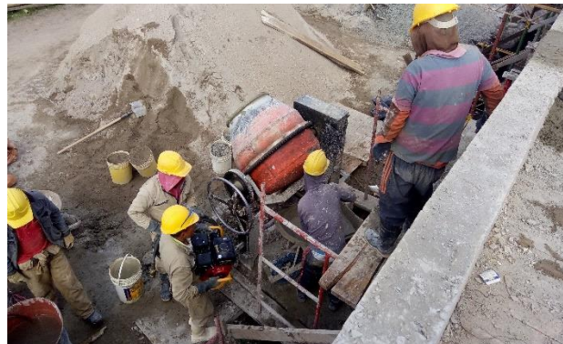
FOTO 24. FUNDICIÓN DE COLUMNAS 2 DO NIVEL - esta actividad se realiza sin contratiempos
