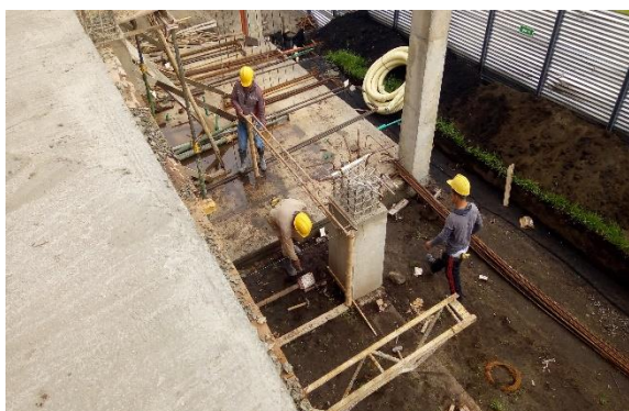
FOTO 21. INSTALACION DE CASETON EN ICOPOR – se realiza sin contratiempos.
