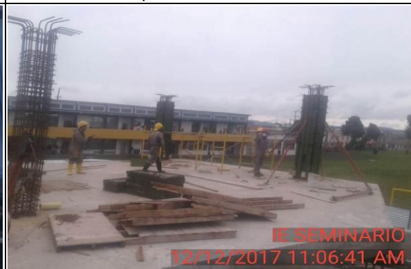
FOTO 37: Instalación de formaleta, para columnas nivel 1.
