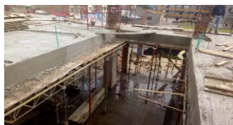
Foto 6. Desencofrado De Losa
