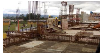
Foto 4. Instalación acero vigas aéreas
