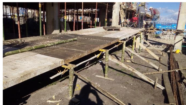
FOTO 30. INSTALACIÓN DE FORMALETA DE RAMPA - esta actividad se realiza sin contratiempos
