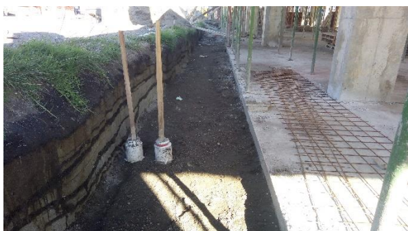
FOTO 25. RELLENO Y COMPACTACIÓN DE FILTRO FRANCÉS – se realiza sin contratiempos.
