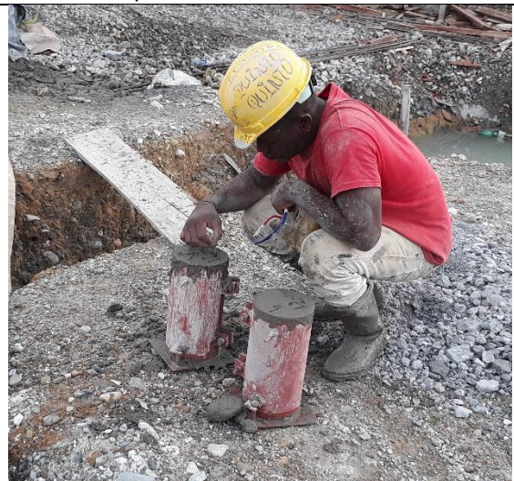
Foto 22: toma de muestras de concreto
