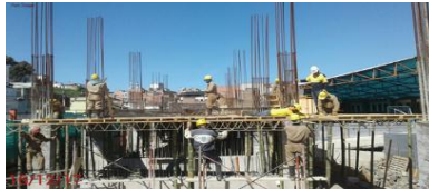
Foto 10-11-12 : Armado de formaleta para losa de primer piso.
