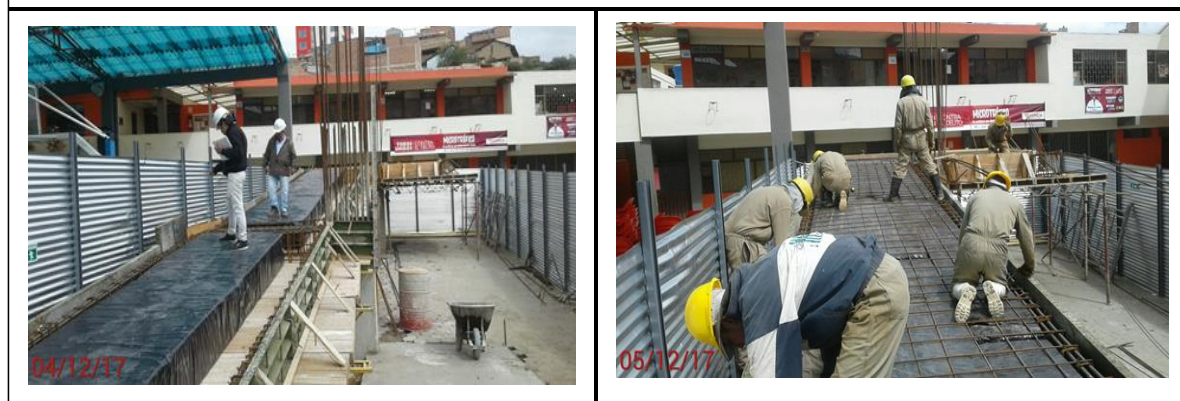
Foto 3-4 : Instalación de icopor y armado de aceros para placa de rampa.
