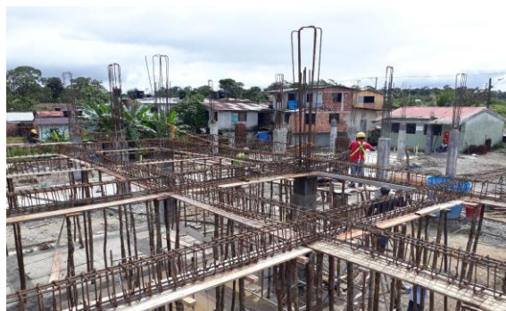
ARMADO E INSTALACION DE VIGAS AEREAS.
