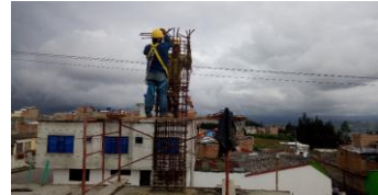
Foto 4. Instalación acero columnas
