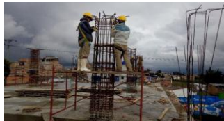
Foto 3. Instalación acero columnas
