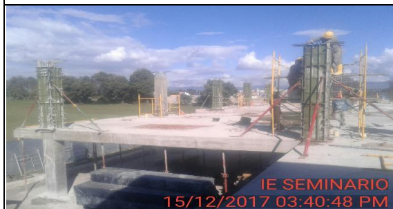
FOTO 16: Vista general ejes 1 y 2.
