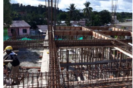
ARMADO DE VOLADIZOS
