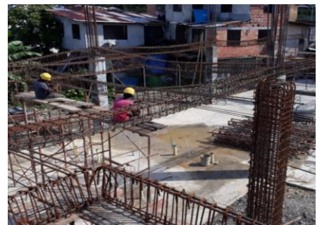
INSTALACION DE VIGAS AEREAS.
