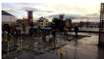
Foto 15. Fundición de Losa de Entrepiso
