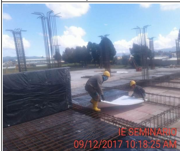
FOTO 29: Instalación de módulos de icopor, para losa de entepiso nivel 1.
