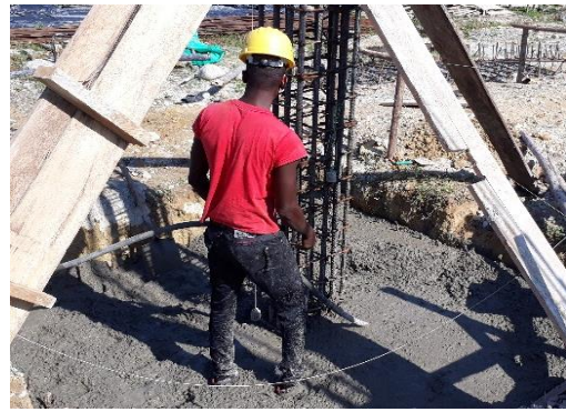
FOTO 14: vibrado de concreto.
