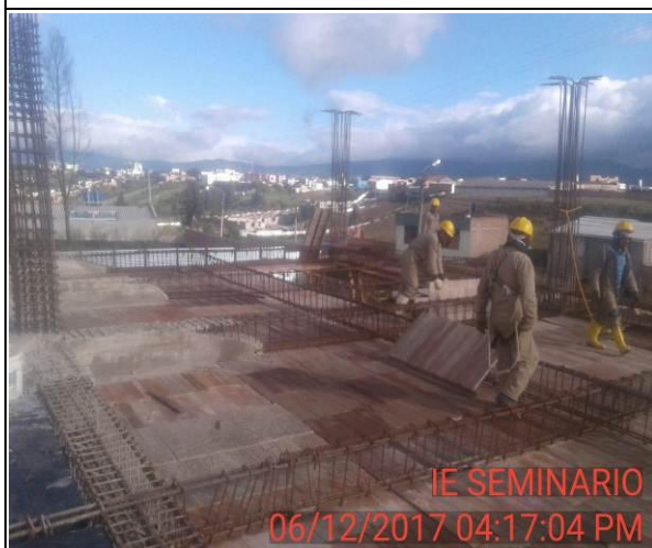
FOTO 23: Vista general armado de tramo de formaleta para losa nivel 1.
