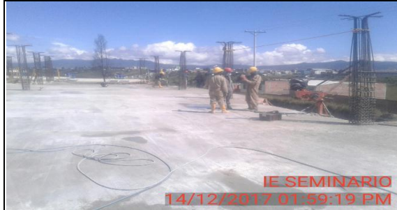
FOTO 12: Vista del tramo de losa de entrepiso nivel 1 fundido
