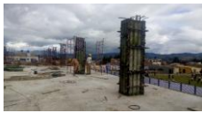
Foto 9. Instalación Formaleta Columnas
