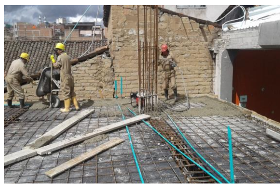
Foto 18 -19 :Fundida de losa .
