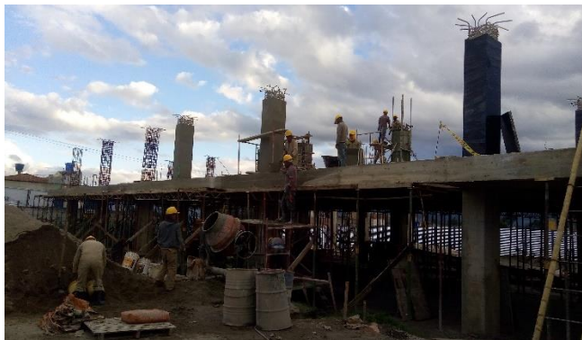
FOTO 23. FUNDICIÓN DE COLUMNAS 2 DO NIVEL - esta actividad se realiza sin contratiempos
