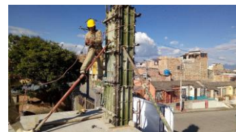
Foto 16. Fundición de Columnas 2do piso
