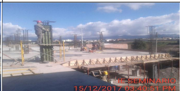
FOTO 17: Vista general ejes 3 y 4.
