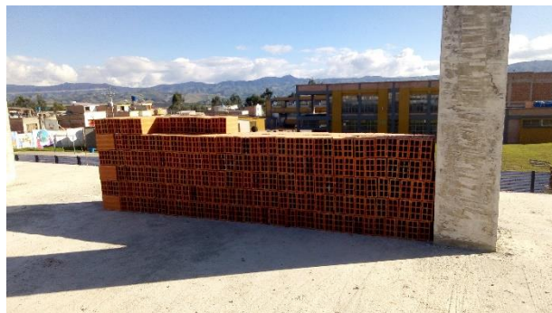
FOTO 28. ACOPIO DE MATERIAL (mampostería) – se realiza sin contratiempos.
