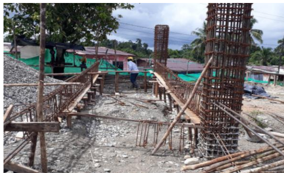
ARMADO E INSTALACION DE VIGAS PARA RAMPA.
