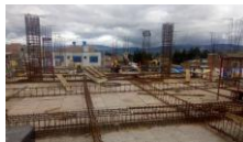
Foto 12. Instalación acero vigas aéreas
