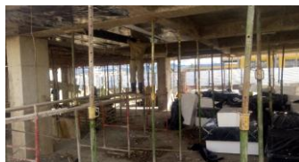
Foto 9. Instalación Formaleta Columnas
