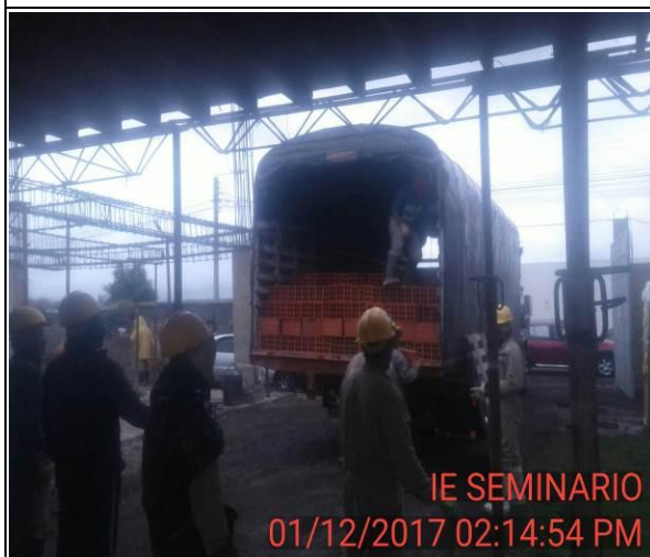
FOTO 14: Llegada de ladrillo farol para divisiones internas de muros.
