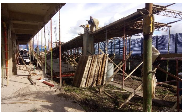
FOTO 33. INSTALACIÓN DE ACERO DE RAMPA DE ACCESO - esta actividad se realiza sin contratiempos
