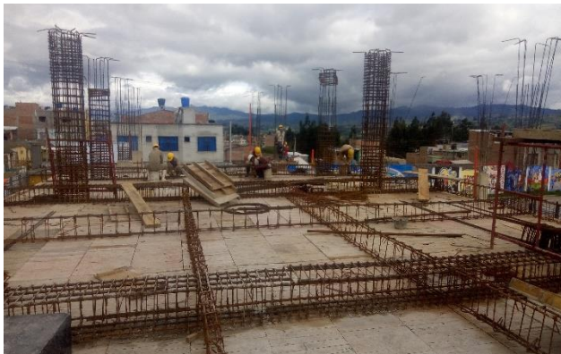
FOTO 3. ARMADO DE ACERO DE LOSA DE ENTREPISO - esta actividad se realiza sin contratiempos
