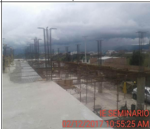
FOTO 15: vista de tramo fundido y tramo sin formaleta.
