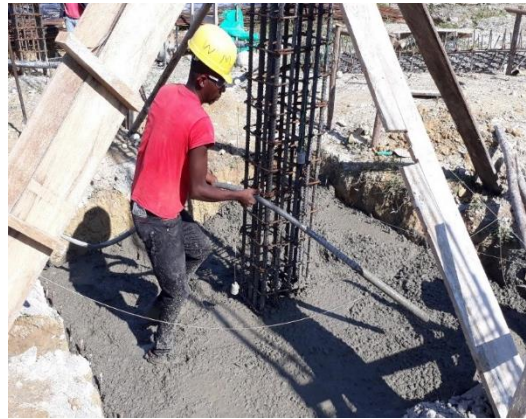
FOTO 12: fundición en concreto para zapatas.
