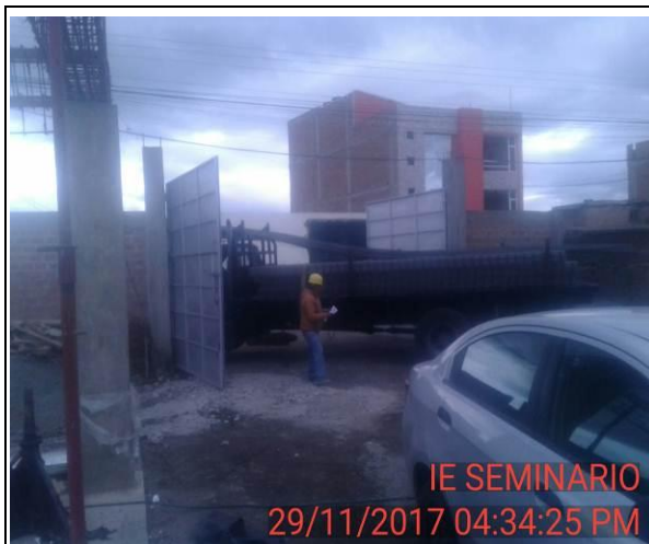
FOTO 4: Llegada de acero para estribos de columnas.
