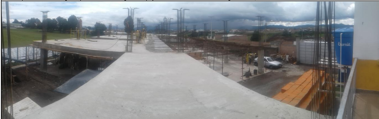
FOTO 1 : VISTA GENERAL DE OBRA: Se observa un 50% de losa de entrepiso nivel 1 fundida y el otro 50% sin formaleta y sin fundir, también se observa inicio de instalación de acero de columnas nivel 2.
