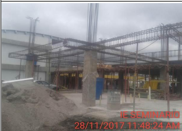
FOTO 2: Tramo de losa de entrepiso nivel 1 sin formaleta.
