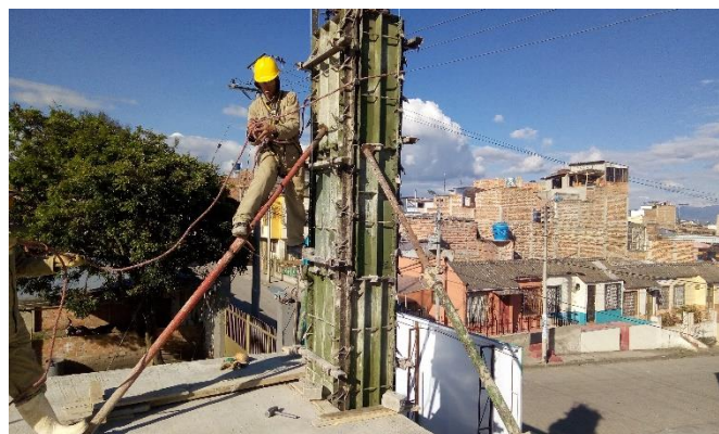
FOTO 20. FUNDICIÓN DE COLUMNAS 2 DO NIVEL - esta actividad se realiza sin contratiempos
