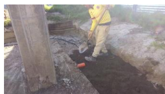
Foto 15. Compactación recebo en filtro francés
