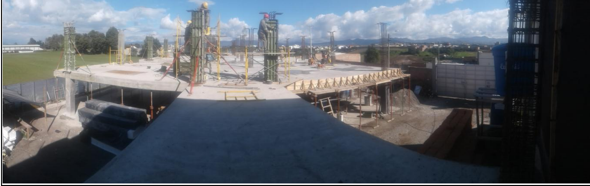
FOTO 1 : Vista panorámica, se observa un 95% de losa de entrepiso nivel 1 fundida y 7 columnas de segundo piso fundidas.
