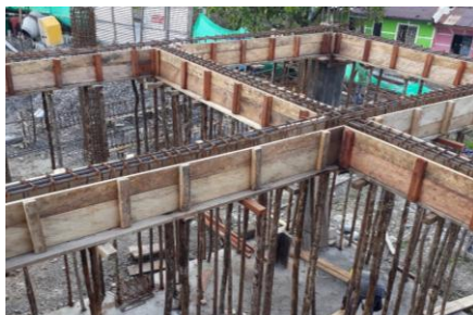
ARMADO DE FORMALETAS PARA VIGAS AEREAS
