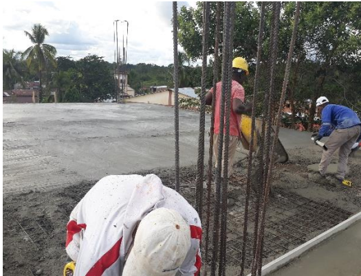
FOTO 13: fundición placa de entre piso.
