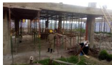
Foto 15. Desencofrado De La Losa
