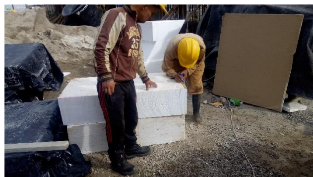
FOTO 10. INSTALACIÓN DE CASETONES DE ICOPOR – sin contratiempos
