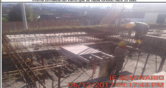
FOTO 10: Inicia instalacion de formaleta para siguiente tramo de losa de entrepiso nivel 1, con la misma formaleta del tramo que se habia fundido hace 10 dias.
