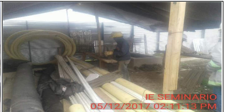
FOTO 5: Continúa corte y figurado de acero para columnas nivel 2.
