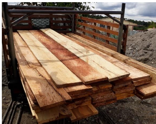
Foto 18: suministro de materiales madera.
