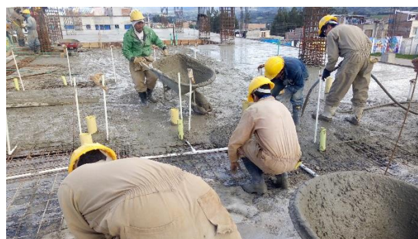
FOTO 16. FUNDICIÓN DE LOSA DE ENTREPISO CCTO 3000 psi - esta actividad se realiza sin contratiempos
