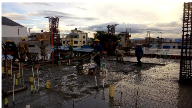
FOTO 17. FUNDICIÓN DE LOSA DE ENTREPISO CCTO 3000 psi - esta actividad se realiza sin contratiempos
