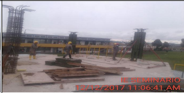
FOTO 5: Instalación de formaleta para columnas de nivel 2.
