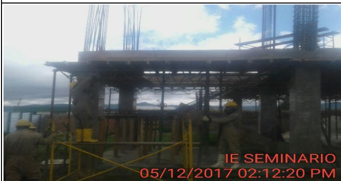
FOTO 6: Se baja formaleta de tramo fundido de losa de entrepiso nivel 1 a los 10 dias, sin tener resultados de cilindros a los 7 dias.
