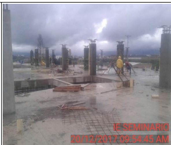
FOTO 50: Vista general columnas fundidas, y columnas con formaleta.
