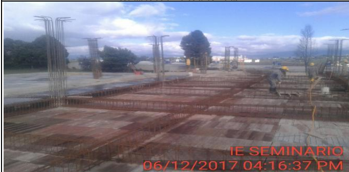
FOTO 8: Inicia instalacion de formaleta para siguiente tramo de losa de entrepiso nivel 1, con la misma formaleta del tramo que se habia fundido hace 10 dias.
