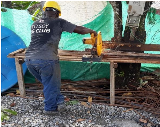
FOTO 5: figurado de acero.
