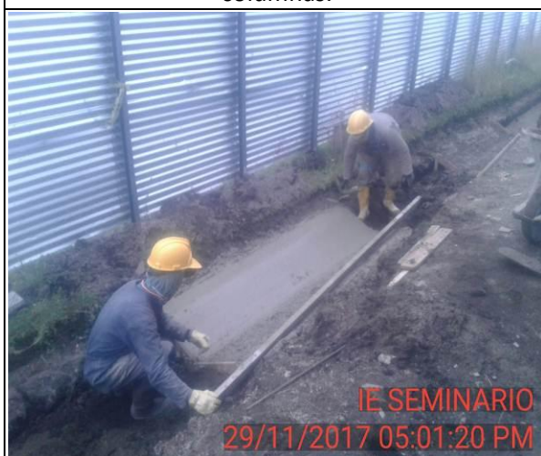
FOTO 6: Continúa fundición concreto cuneta perimetral.
