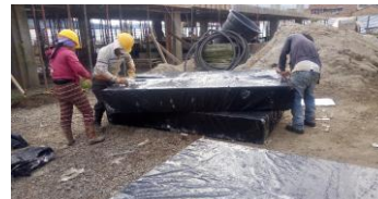
Foto 7. Instalación Casetones De Icopor
