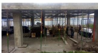
Foto 2. Desencofrado De Losa
