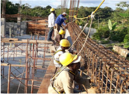
ARMADO E INSTALACION DE VIGAS AEREAS.
