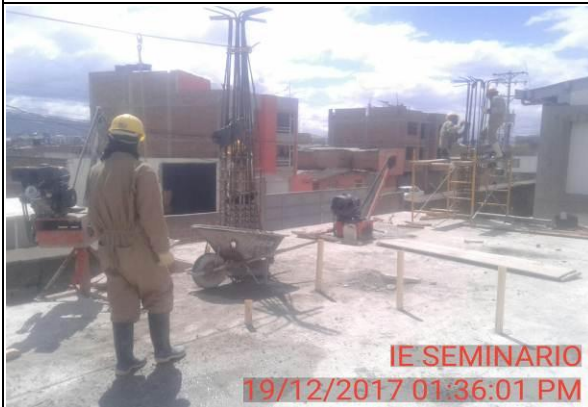
FOTO 47: Fundición concreto de 3000 psi hecho en obra para columnas nivel 2.
