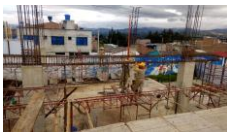
Foto 14. Instalación acero vigas aéreas
