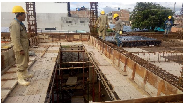
FOTO 11. INSTALACIÓN DE FORMALETA EN LOSA DE ENTREPISO - esta actividad se realiza sin contratiempos
