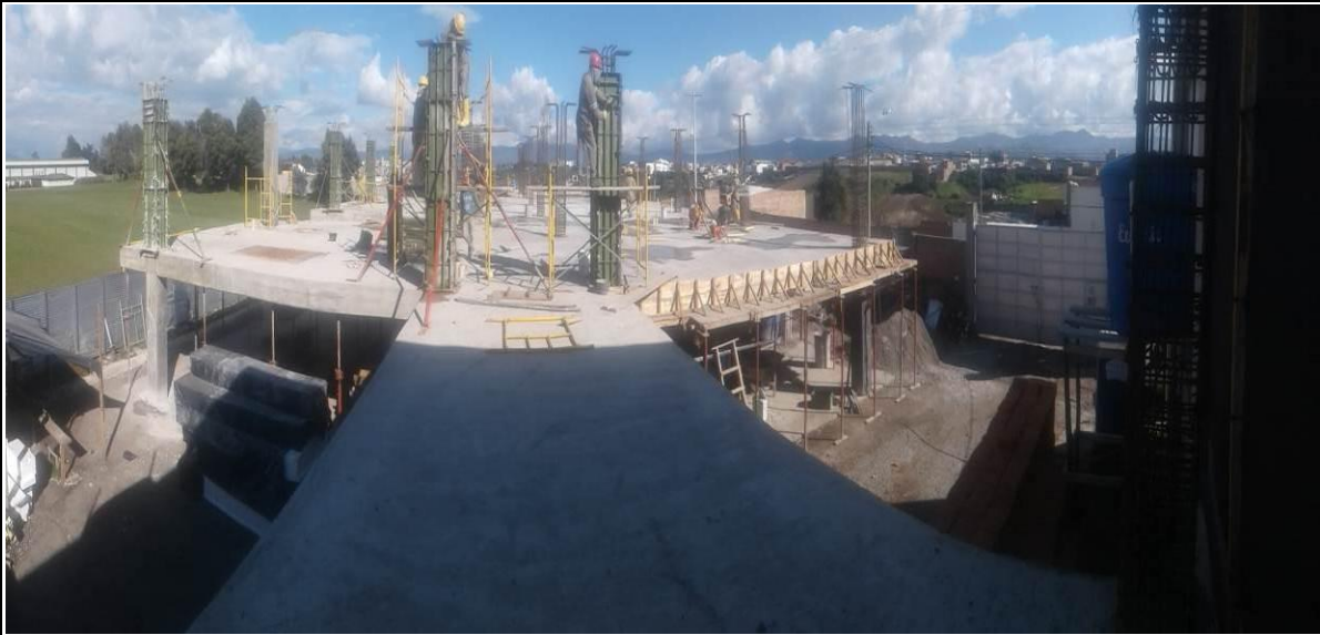
FOTO 33: Vista panorámica, se observa un 95% de losa de entepiso nivel 1 fundida, también se inicia con la fundición de concreto de 3000 psi para columnas nivel 2.
