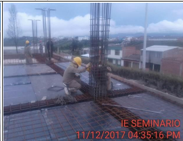
FOTO 35: Continúa instalación de acero, estribos para columnas de nivel 2.
