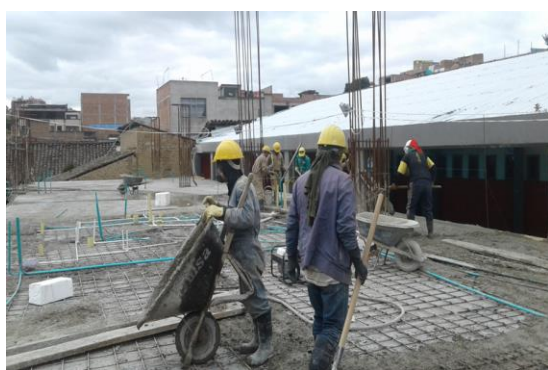
Foto 20 -21 : Fundida de losa .
