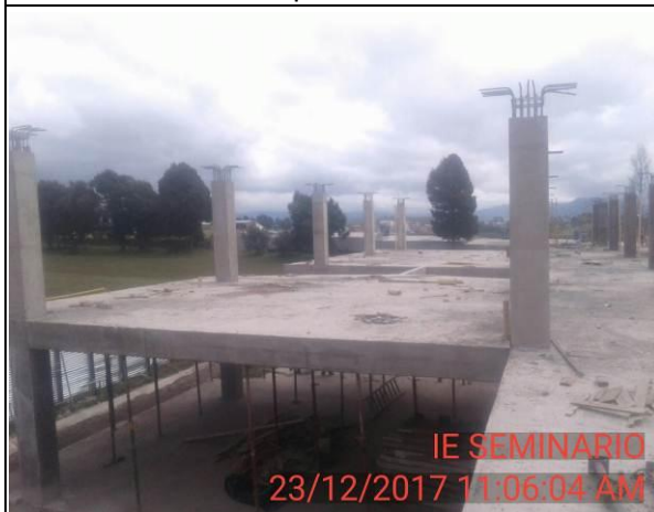
FOTO 53: Vista general ejes 1 y 2.
