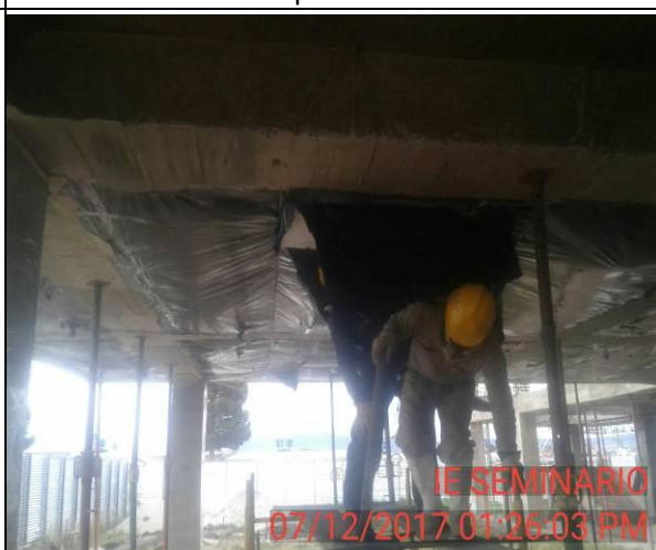
FOTO 24: Desmonte tramo de formaleta fundida, para losa de entrepiso nivel 1.
