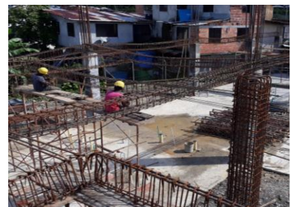
INSTALACION DE VIGAS AEREAS.
