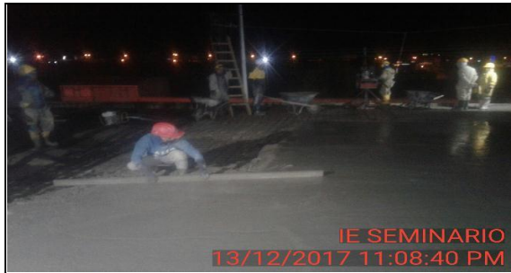
FOTO 10: Fundicion concreto de 3000 psi mezclado en obra para tercer tramo de losa de entrepiso nivel 1.
