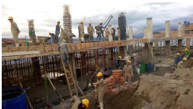
FOTO 15. FUNDICIÓN DE LOSA DE ENTREPISO CCTO 3000 psi - esta actividad se realiza sin contratiempos
