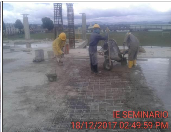
FOTO 46: Fundición concreto de 3000 psi 4to tramo de losa de entrecimso nivel 1.
