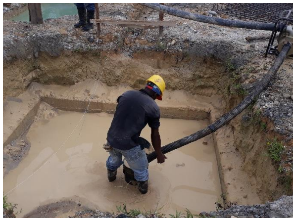
FOTO 10: mantenimiento a excavaciones
