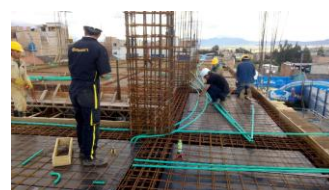
Foto 13. Instalación tubería conduit
