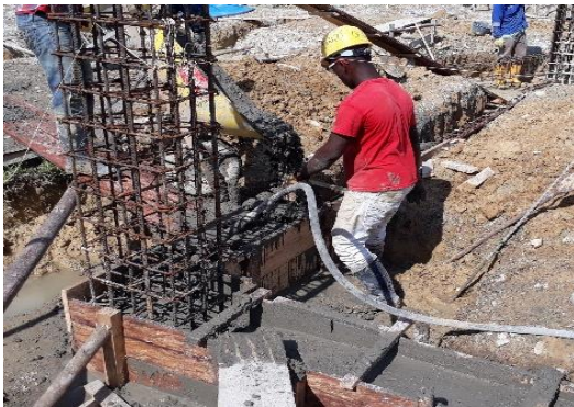
FOTO 13: fundición de concreto para vigas de cimentación.
