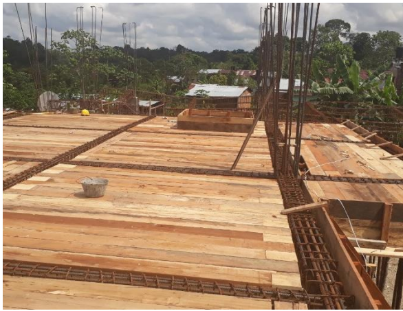
FOTO 7: formaleta en madera para losa.
