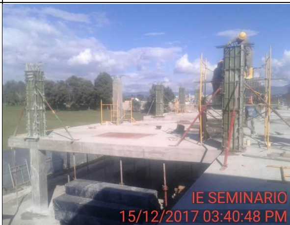
FOTO 43: Inicia fundición de concreto de 3000 psi hecho en obra, para columnas nivel 2.
