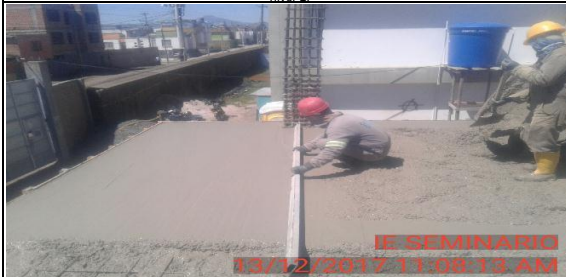
FOTO 8: Fundición concreto de 3000 psi mezclado en obra para tercer tramo de losa de entrepiso nivel 1.
