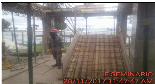
FOTO 4: Continúa armado de acero para escalera 1.
