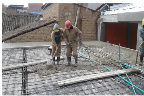
Foto 18 -19 :Fundida de losa .
