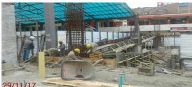
Foto 7-8-9: Armado de aceros para rampa.
