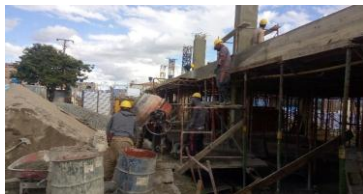
Foto 8. Fundición de Columnas 2do piso
