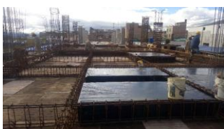
Foto 11. Instalación Casetones De Icopor
