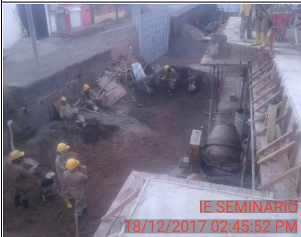
FOTO 45: Fundición concreto de 3000 psi 4to tramo de losa de entrecimso nivel 1.
