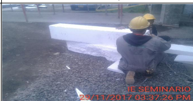
FOTO 5: Continúa modulación de icopor para el otro tramo de losa de entrepiso nivel 1.
