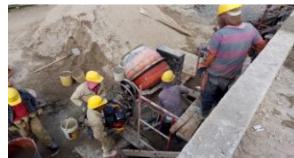
Foto 9. Fundición de Columnas 2do piso
