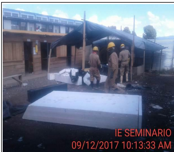
FOTO 27: Corte de icopor, para tramo de losa de entepiso nivel 1.
