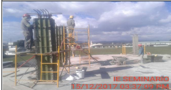
FOTO 14: Inicia fundicion concreto de 3000 psi mezclado en obra para columnas nivel 2.
