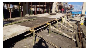
Foto 13. Instalación formaleta para rampa
