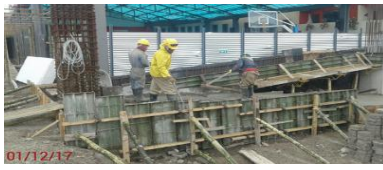
Foto 10-11-12 : Inicio fundición de rampa.
