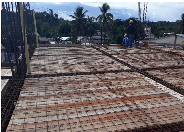
FOTO 9: malla electro soldada.
