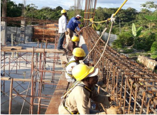
ARMADO E INSTALACION DE VIGAS AEREAS.
