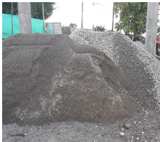
Foto 16: suministro de materiales agregados.
