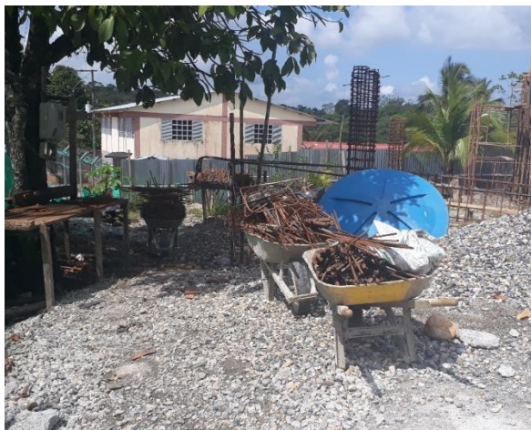
Foto 21: limpieza y aseo de obra
