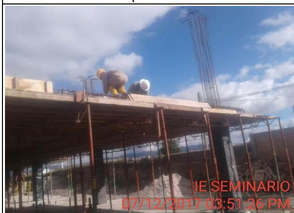
FOTO 25: Instalación de tableros laterales, para losa de entrepiso nivel 1.
