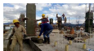
Foto 7. Fundición de Columnas 2do piso
