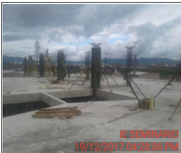
FOTO 49: Vista general columnas fundidas, y columnas con formaleta.
