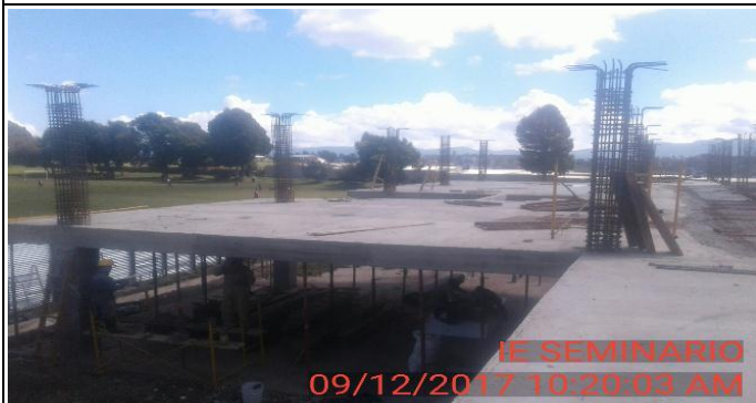
FOTO 16: Vista general ejes 1 y 2.
