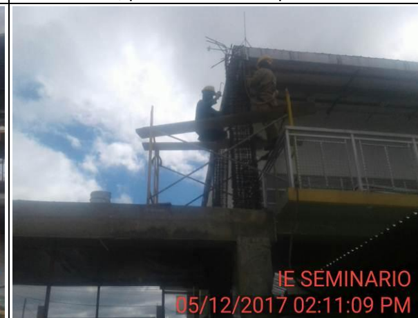
FOTO 20: Instalación de acero, estribos para columnas nivel 2.
