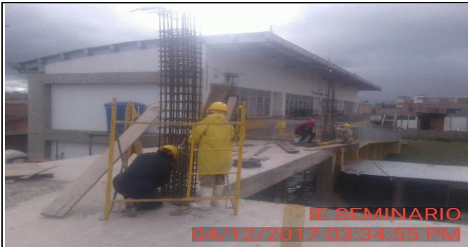
FOTO 4: Continúa instalacion de acero, estribos para columnas nivel 2.
