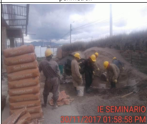
FOTO 7: Concreto de 3000 psi para tramo pequeño de losa de entepiso nivel 1.
