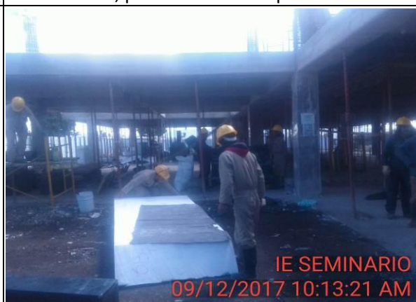
FOTO 26: Corte de icopor, para tramo de losa de entrepiso nivel 1.
