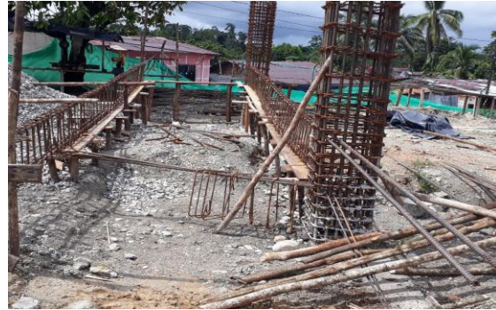
ARMADO E INSTALACION DE VIGAS PARA RAMPA.
