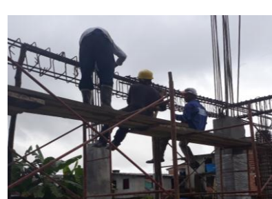
INSTALACION DE VIGAS AEREAS.
