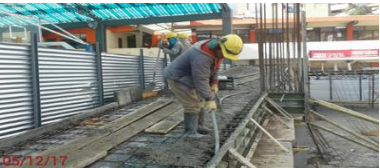
Foto 10-11-12 : continua fundición de rampa.
