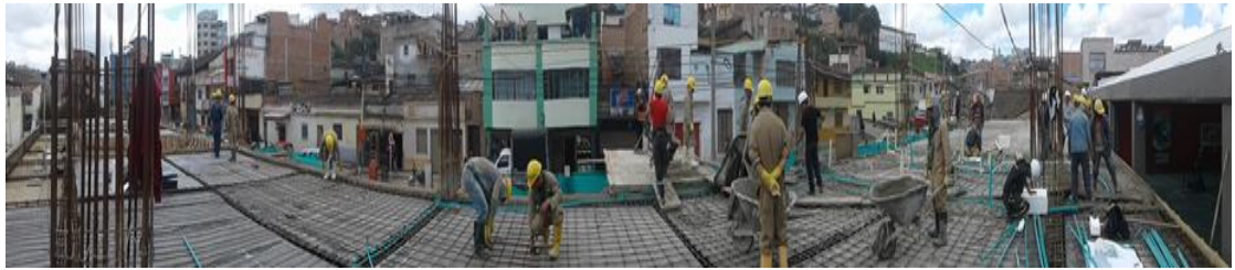
Foto 5: Panorámica general de la Fundición de losa.
