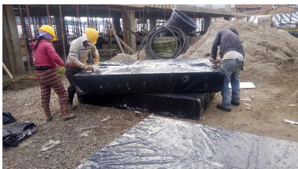
FOTO 9. INSTALACIÓN DE CASETONES DE ICOPOR – sin contratiempos
