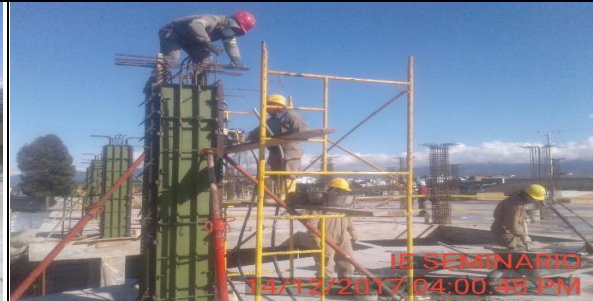
FOTO 13: Inicia fundicion concreto de 3000 psi mezclado en obra para columnas nivel 2.
