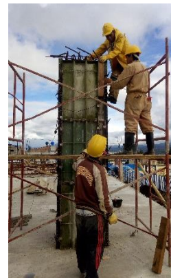
FOTO 4. FUNDICIÓN DE COLUMNAS 2 DO NIVEL - esta actividad se realiza sin contratiempos
