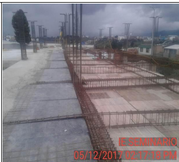
FOTO 22: Vista general armado de tramo de formaleta para losa nivel 1.
