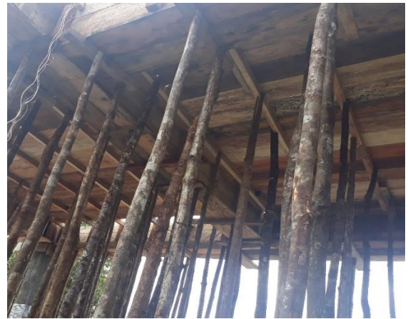
FOTO 8: tacos en madera para estabilidad de losa
