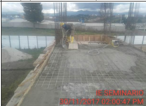
FOTO 9: Fundición de concreto de 3000 psi para losa de entepiso nivel 1, tramo pequeño.
