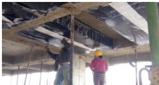
Foto 3. Retiro De Casetones
