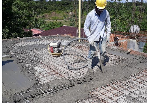
FOTO 12: vibrado de concreto.
