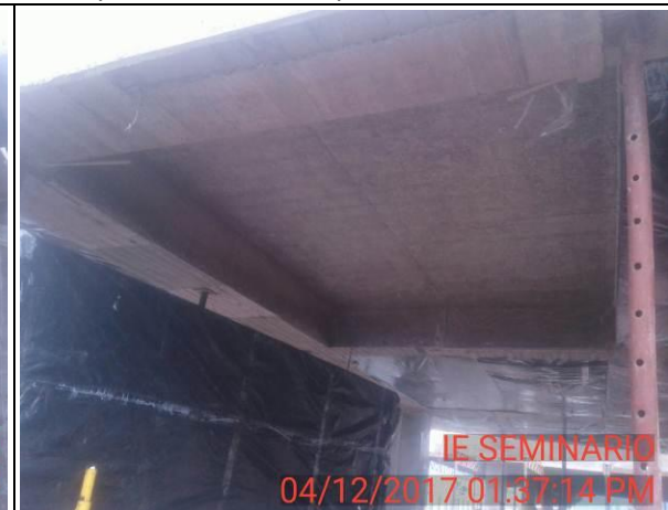
FOTO 18: Desmonte tramo de formaleta fundida, para losa de entrepiso nivel 1.
