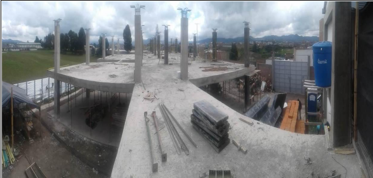
FOTO 44: Vista panorámica, se observa fundida al 100% la losa de entrecimso nivel 1 y fundidas todas las columnas de nivel 2.
