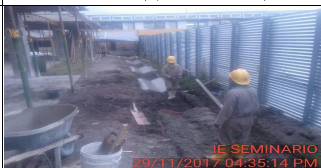
FOTO 7: Conformación de canal perimetral en concreto.
