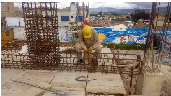
FOTO 5. INSTALACIÓN DE ACERO DE VIGAS AÉREAS - esta actividad se realiza sin contratiempos
