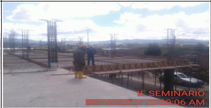
FOTO 17: Vista general ejes 3 y 4.
