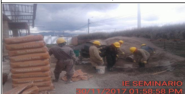
FOTO 6: Mezcla de concreto para canal
