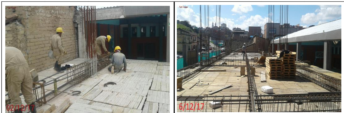
Foto 10 - 11: Armado de aceros para vigas aéreas.
