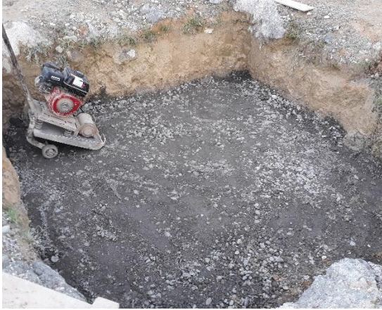
FOTO 11: recebo cemento bajo zapatas.
