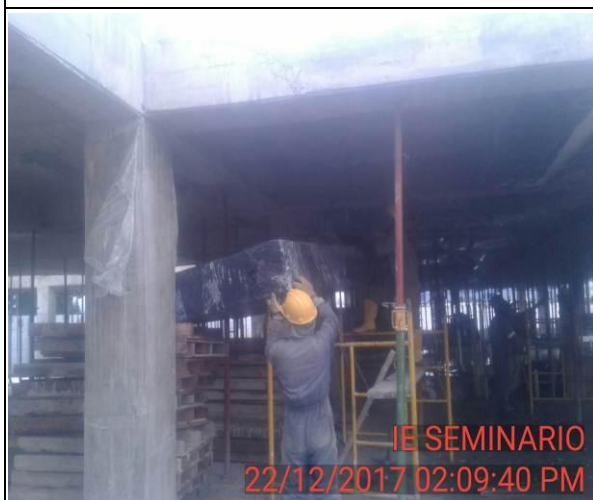
FOTO 51: Desencofrado de 4to tramo de los de entepiso nivel 1.
