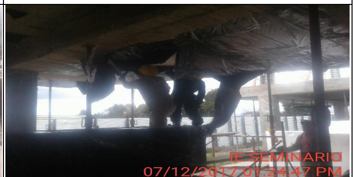
FOTO 11: Se baja formaleta (icopor) de tramo fundido de losa de entrepiso nivel 1 a los 10 dias, sin tener resultados de cilindros a los 7 dias.
