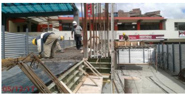
Foto 7-8-9: Instalación de icopor y Armado de aceros para la losa de la rampa.
