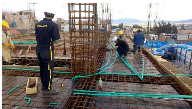
FOTO 13. INSTALACIÓN TUBERIA CONDUIT - esta actividad se realiza sin contratiempos
