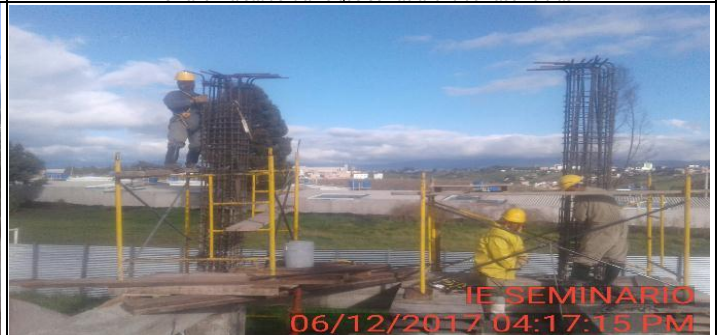
FOTO 9: Continúa instalacion de acero, estribos para columnas nivel 2.
