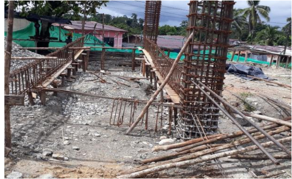
ARMADO E INSTALACION DE VIGAS PARA RAMPA.
