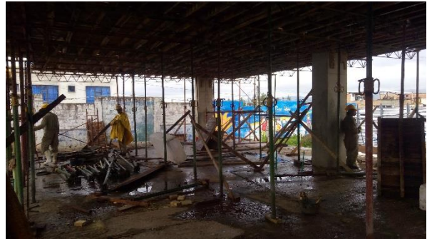
FOTO 2. DESMONTE DE FORMALETA - esta actividad se realiza sin contratiempos
