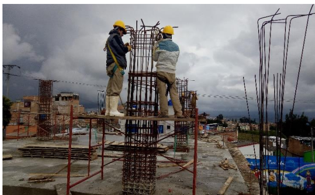
FOTO 19. INSTALACIÓN DE ACERO DE COLUMNAS - esta actividad se realiza sin contratiempos
