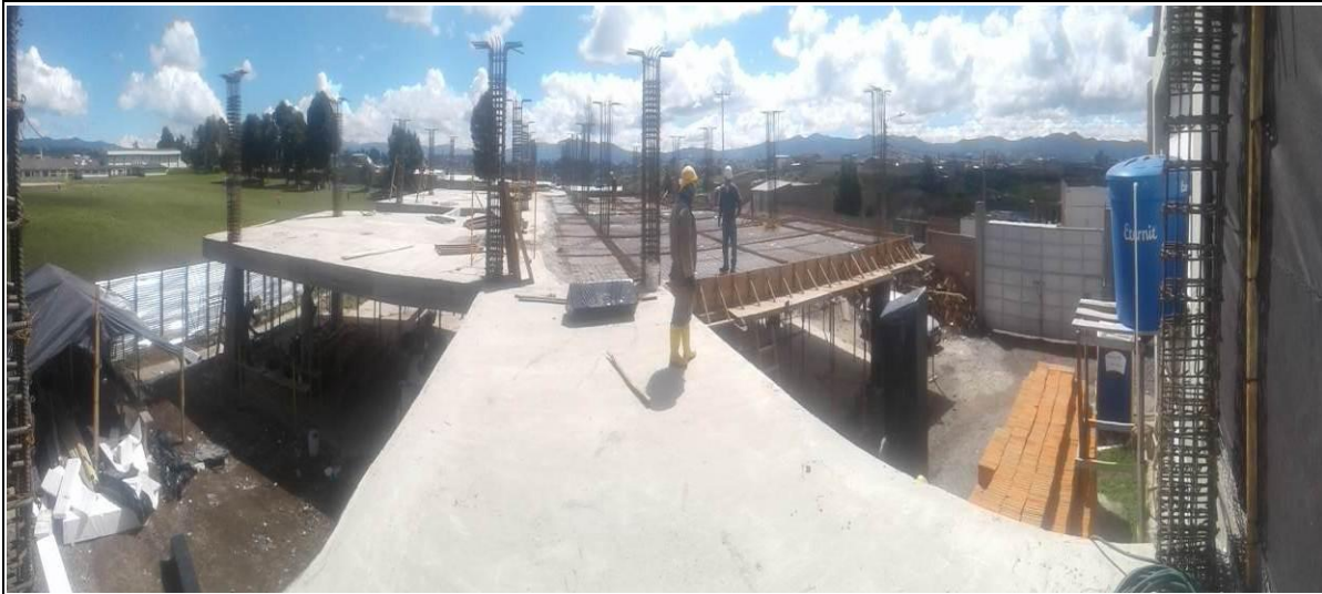
FOTO 16: Vista panorámica, se observa avance de instalación de acero para columnas nivel 2, también se observa armado de formaleta, para losa de entrepiso nivel 2.
