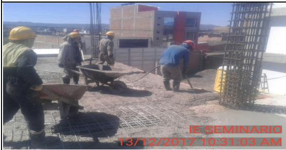
FOTO 6: Fundición concreto de 3000 psi mezclado en obra para tercer tramo de losa de entrepiso nivel 1.
