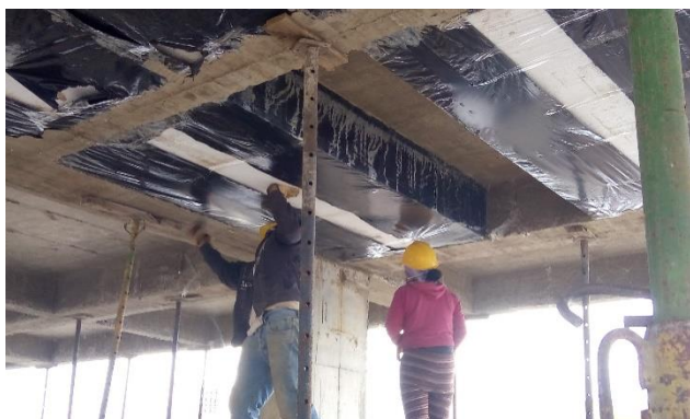
FOTO 7. DESENCOFRADO DE LOSA - esta actividad se realiza sin contratiempos
