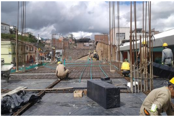
Foto 16-17: Instalacion de ducteria eléctrica.
