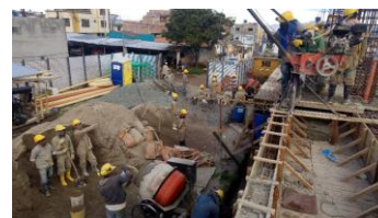
Foto 16. Fundición de Losa de Entrepiso
