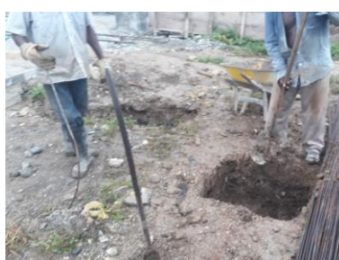
EXCAVACION PARA CAJA DE INSPECCION.
