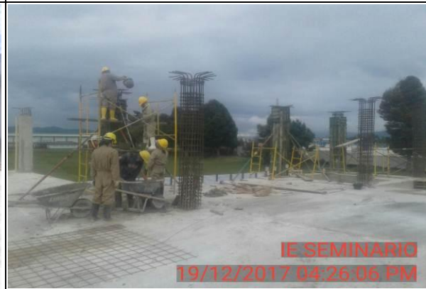
FOTO 48: Fundición concreto de 3000 psi hecho en obra para columnas nivel 2.
