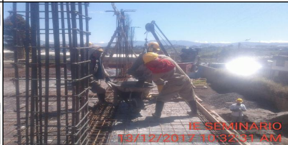
FOTO 7: Fundición concreto de 3000 psi mezclado en obra para tercer tramo de losa de entrepiso nivel 1.
