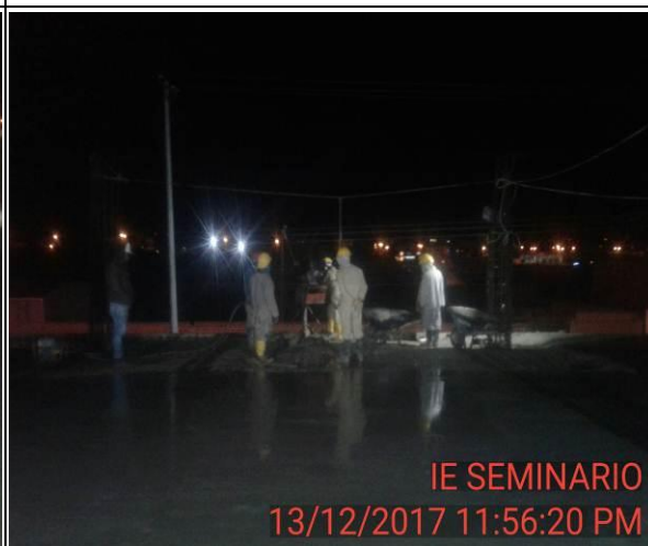
FOTO 41: Fundición concreto de 3000 psi mezclado en obra de 3er tramo losa nivel 1.
