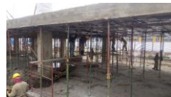
Foto 16. Desencofrado De La Losa
