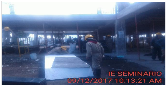
FOTO 13: Inicia instalacion de modulos de icopor para ultimo tramo de losa de entrepiso nivel 1.
