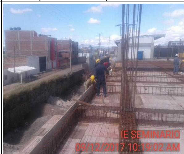
FOTO 30: Instalación de tableros laterales, para losa de entepiso nivel 1.
