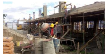
Foto 7. Fundición de Columnas 2do piso
