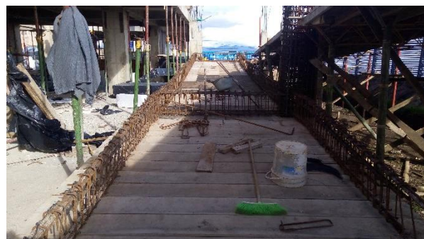
FOTO 32. INSTALACIÓN DE ACERO DE RAMPA DE ACCESO - esta actividad se realiza sin contratiempos
