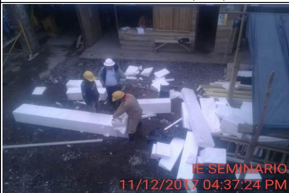
FOTO 36: Continúa modulación de icopor para tercer tramo de losa nivel 1.
