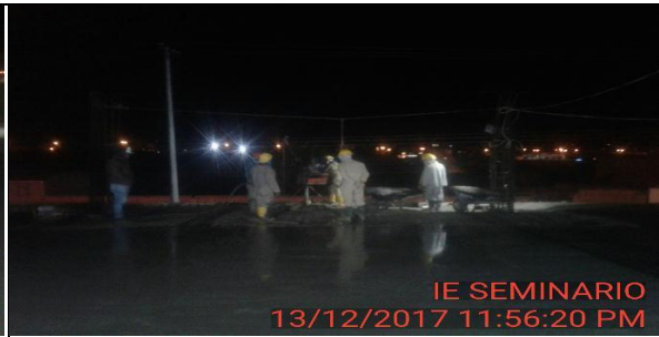
FOTO 11: Fundicion concreto de 3000 psi mezclado en obra para tercer tramo de losa de entrepiso nivel 1.
