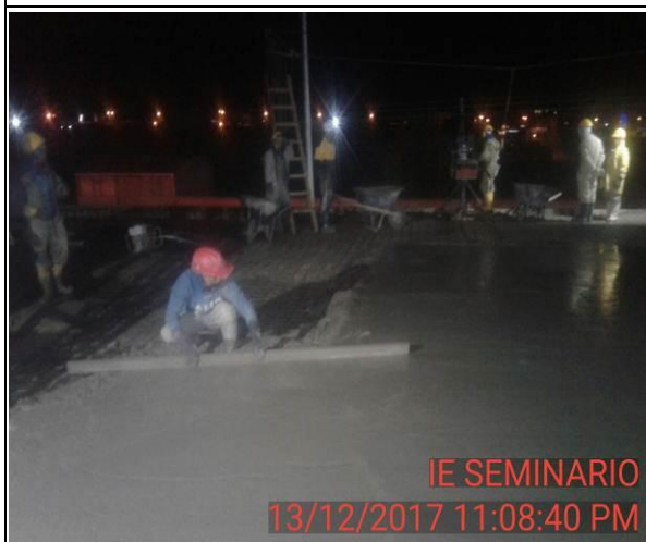
FOTO 40: Fundición concreto de 3000 psi mezclado en obra de 3er tramo losa nivel 1.
