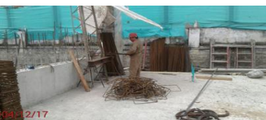
Foto 13-14-15: Corte y figurado de aceros para vigas aéreas.
