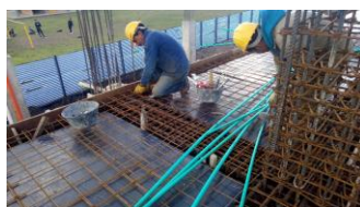
Foto 12. Instalación tubería conduit
