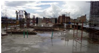
Foto 5. Instalación acero columnas
