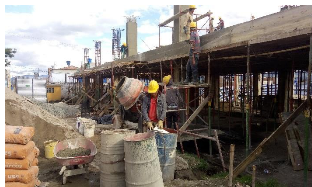
FOTO 22. FUNDICIÓN DE COLUMNAS 2 DO NIVEL - esta actividad se realiza sin contratiempos
