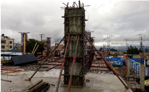
FOTO 1. FUNDICIÓN DE COLUMNAS 2 DO NIVEL - esta actividad se realiza sin contratiempos
