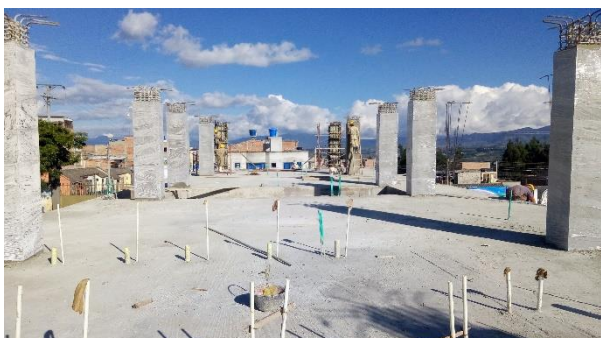
FOTO 31. INSTALACIÓN DE ACERO DE COLUMNAS - esta actividad se realiza sin contratiempos
