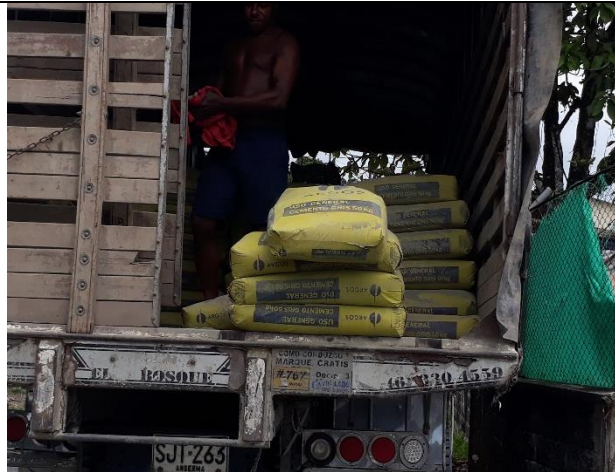
Foto 19: suministro de cemento.
