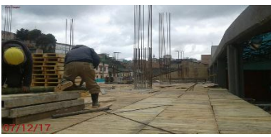
Foto 4-5-6: Armado de formaleta para losa de primer piso.
