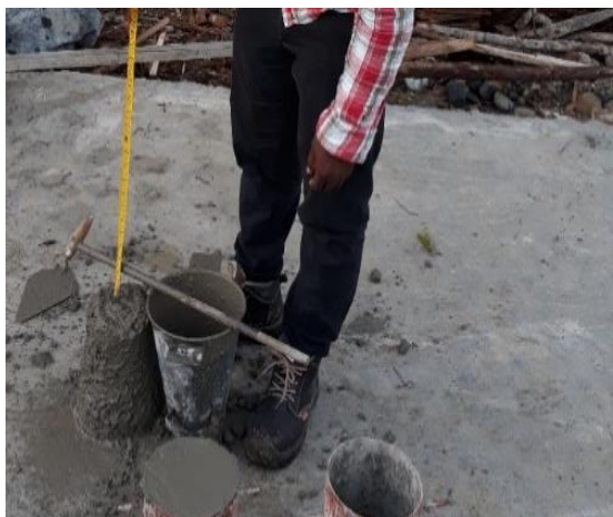
Foto 15: ensayo de Slum.
