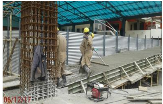
Foto 6-7: Fundición de rampa.
