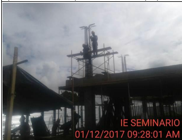
FOTO 12: Instalación de estribos para columnas nivel 2.
