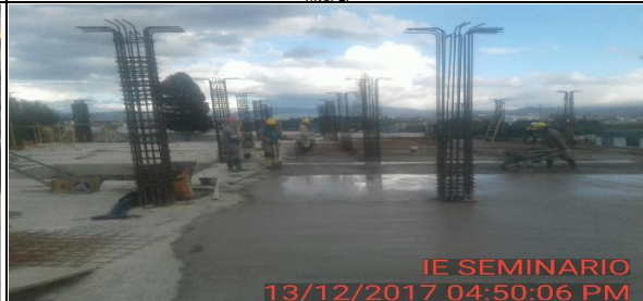
FOTO 9: Fundición concreto de 3000 psi mezclado en obra para tercer tramo de losa de entrepiso nivel 1.
