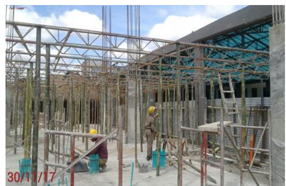
Foto 8 - 9: Encofrado para losa de primer piso.
