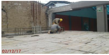
Foto 1-2-3: Armado de aceros para vigas aéreas.
