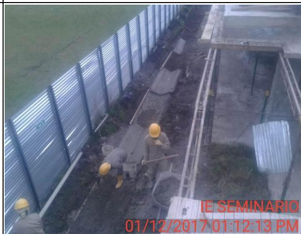
FOTO 13: Continua fundición concreto para cuneta perimetral.
