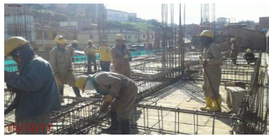
Foto 7-8-9: Armado de aceros para vigas aéreas para losa.
