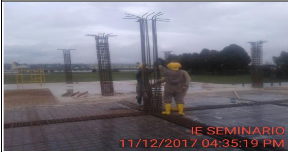
FOTO 4: Continua instalación de acero, estribos para columnas de nivel 2.
