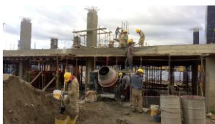
Foto 11. Fundición de Columnas 2do piso
