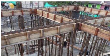
ARMADO DE FORMALETAS PARA VIGAS AEREAS
