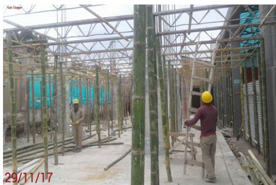
Foto 8 - 9: Encofrado para losa de primer piso.
