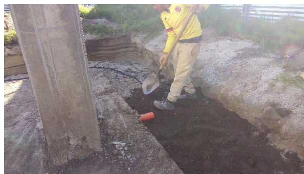
FOTO 26. RELLENO Y COMPACTACIÓN DE FILTRO FRANCÉS – se realiza sin contratiempos.
