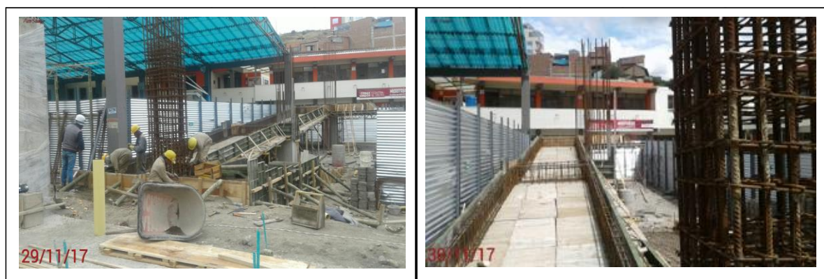
Foto 1-2: Armado de aceros para rampa.
