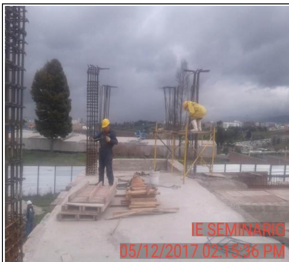
FOTO 21: Instalación de acero, estribos para columnas nivel 2.
