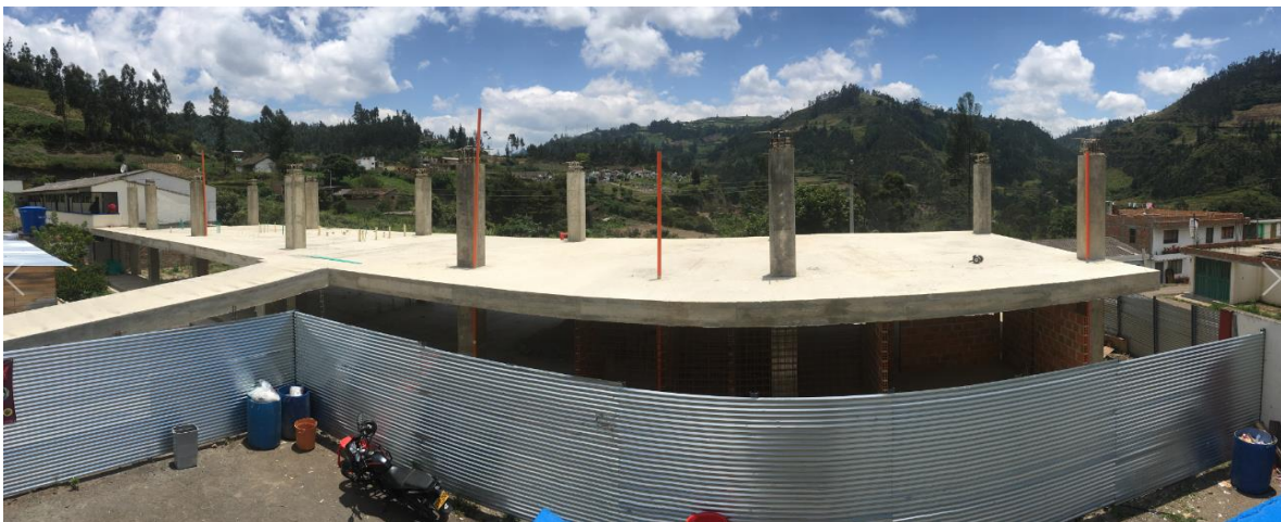
PANORAMICA ESTADO ACTUAL OBRA
