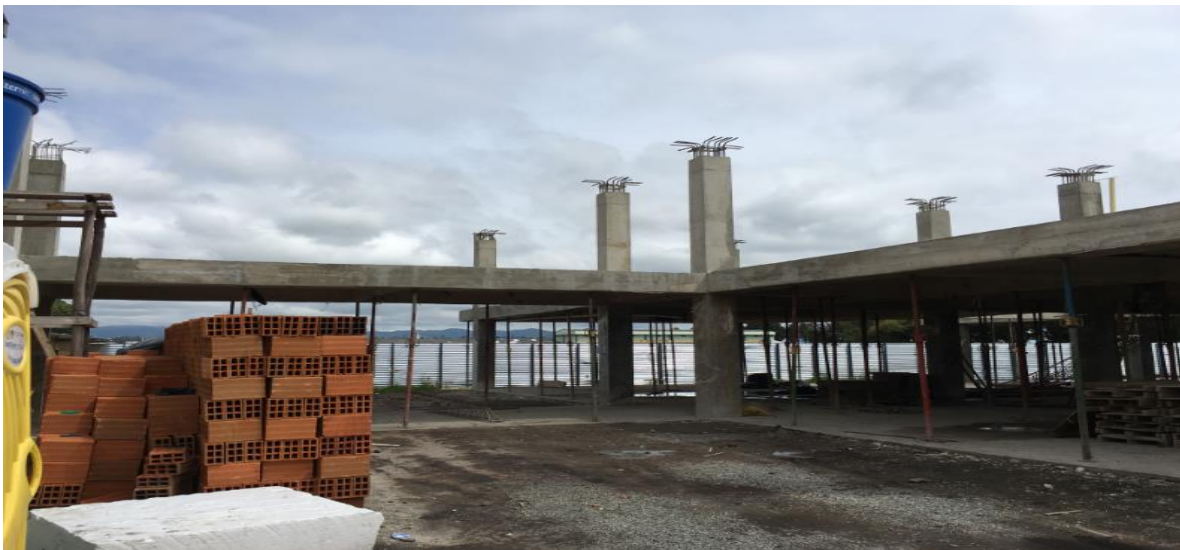
PANORAMICA ESTADO ACTUAL OBRA
