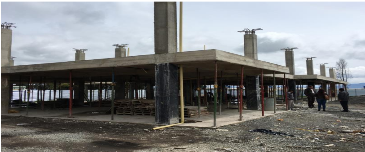
PANORAMICA ESTADO ACTUAL OBRA
