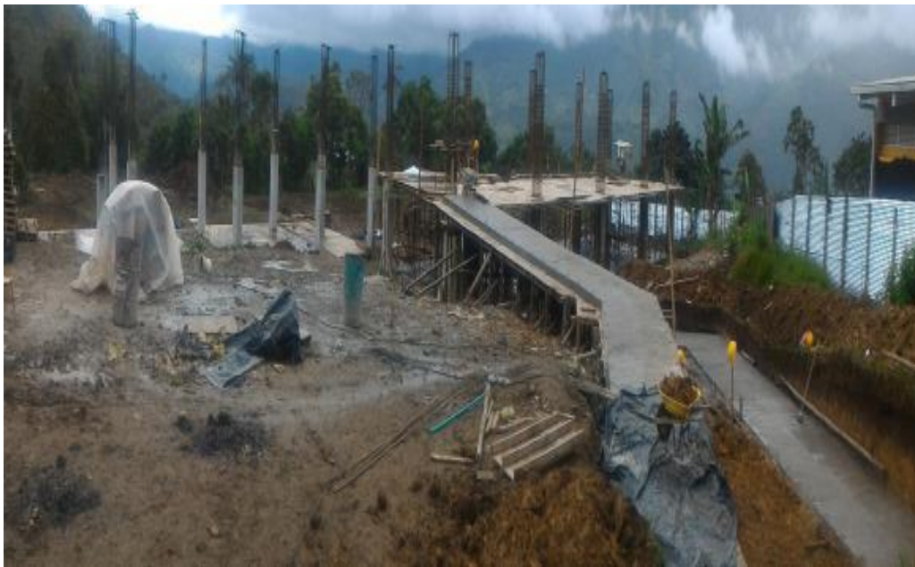
PANORAMICA ESTADO ACTUAL OBRA
