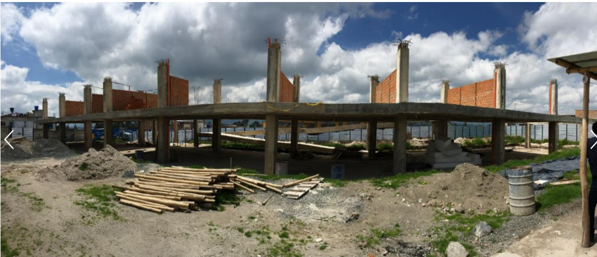
PANORAMICA ESTADO ACTUAL OBRA
