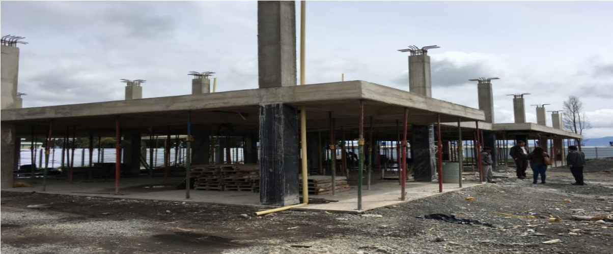
PANORAMICA ESTADO ACTUAL OBRA
