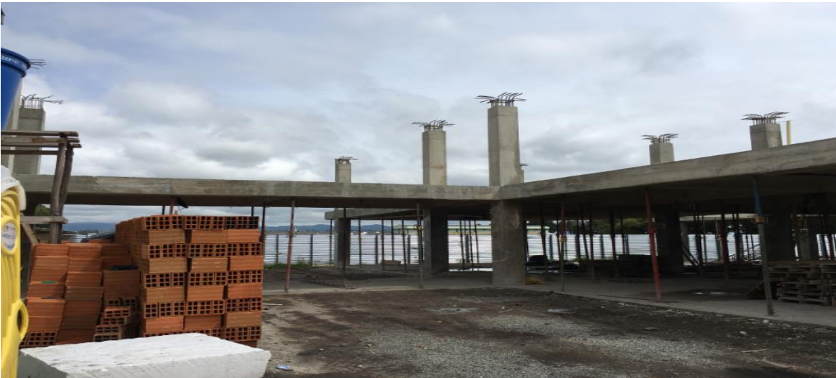
PANORAMICA ESTADO ACTUAL OBRA
