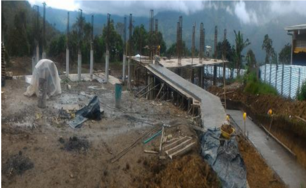
PANORAMICA ESTADO ACTUAL OBRA
