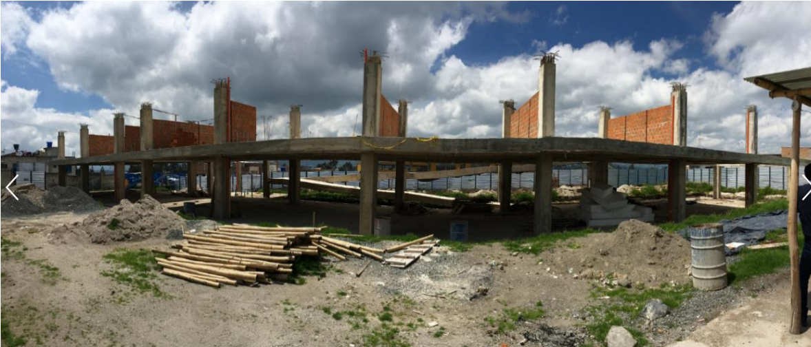
PANORAMICA ESTADO ACTUAL OBRA
