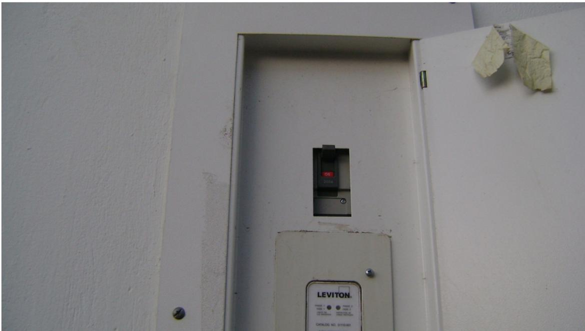
IMAGEN 2 TABLERO TRIFÁSICO 42 CTS. CON SUPRECIÓN DE SOBRETENSIÓN.
