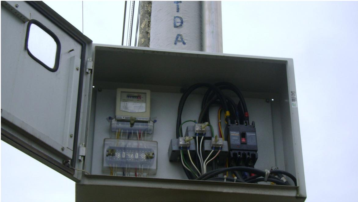
IMAGEN DE EQUIPO DE MEDIDA ELECTRÓNICO CON BORNERA DE PRUEBA T.C Y TOTALIZADOR.
