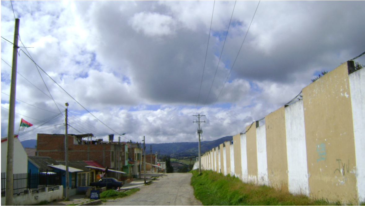
IMAGEN 2 ESTRUCTURA RED MEDIA TENSIÓN.
