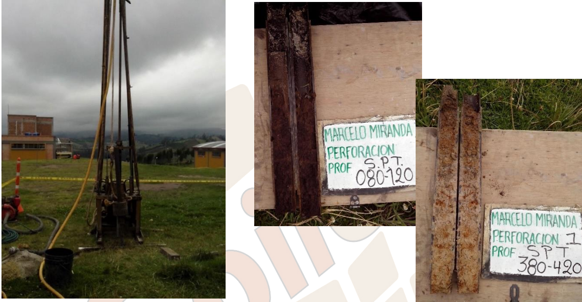
Fotografías 3 a 5. Exploraciones de campo y estratigrafía Perforación P-1
