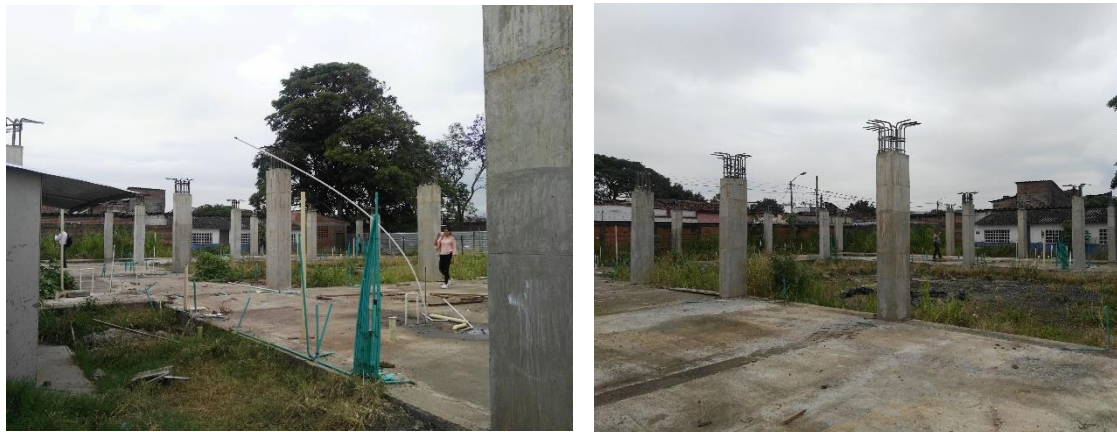
PANORAMICA ESTADO ACTUAL DE LA OBRA
