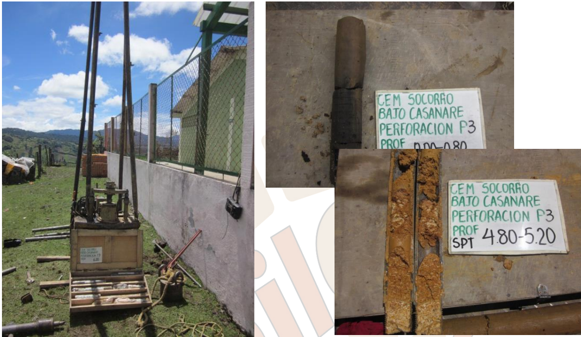
Fotografías 9 a 11. Exploraciones de campo y estratigrafía Perforación P-3
