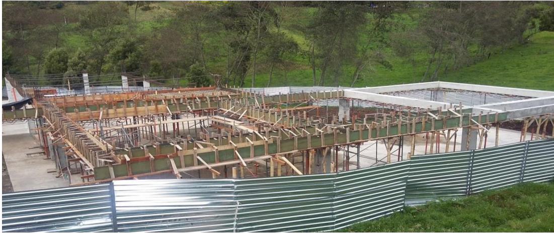
ESTADO ACTUAL OBRA
