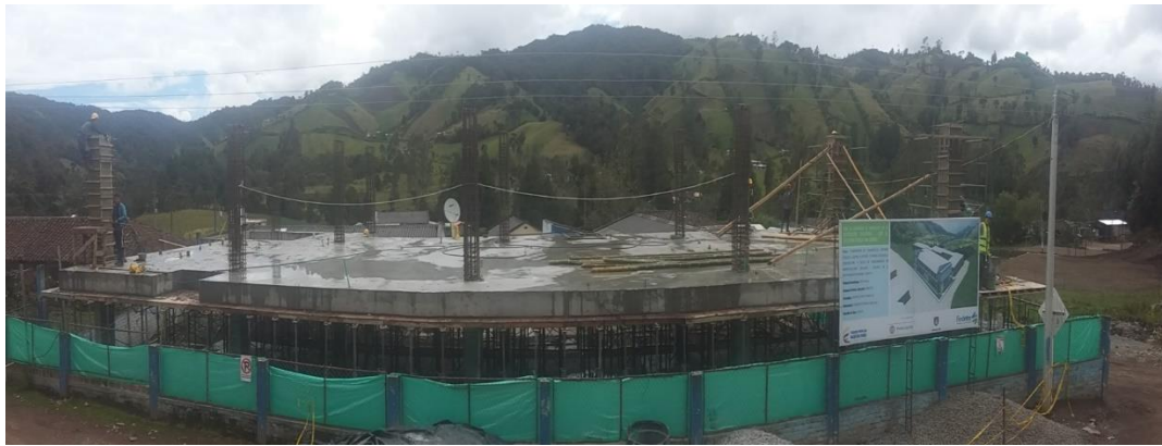
ESTADO ACTUAL OBRA
