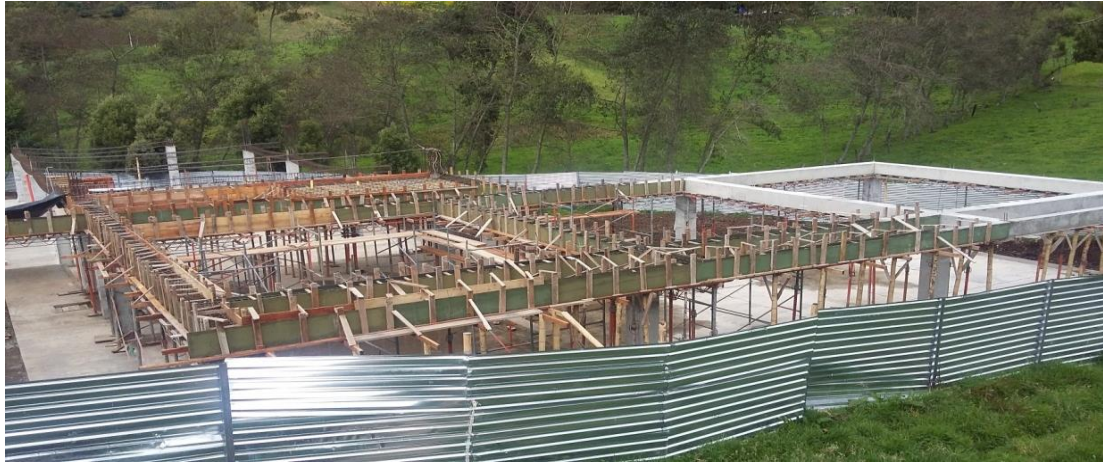
PANORAMICA ESTADO ACTUAL OBRA
