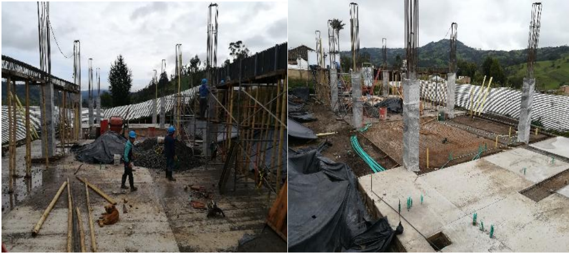
PANORAMICA ESTADO ACTUAL OBRA
