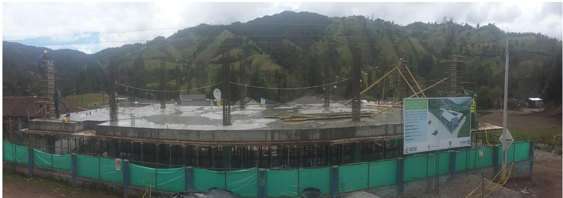
PANORAMICA ESTADO ACTUAL OBRA
