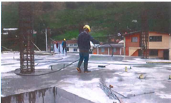
FOTO 5 CURADO CON AGUA LOSA DE ENTREPISO
