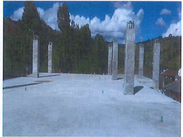
FOTO 8. PLACA Y COLUMNAS
