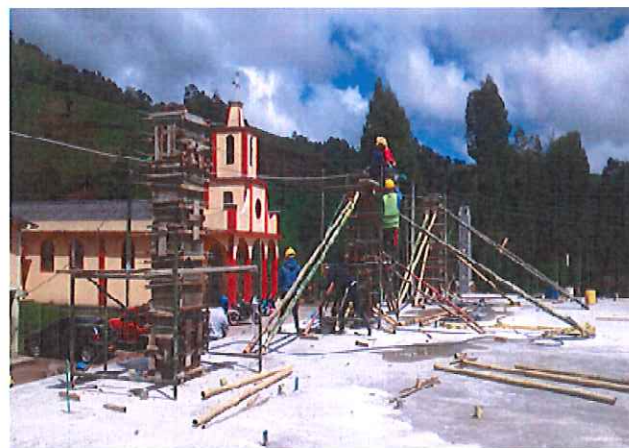
FOTO 3 FUDICION COLUMNAS 2 PISO
