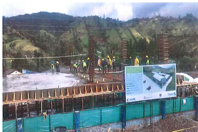
FOTO 2. FUNDICION PLACA DE ENTREPISO
