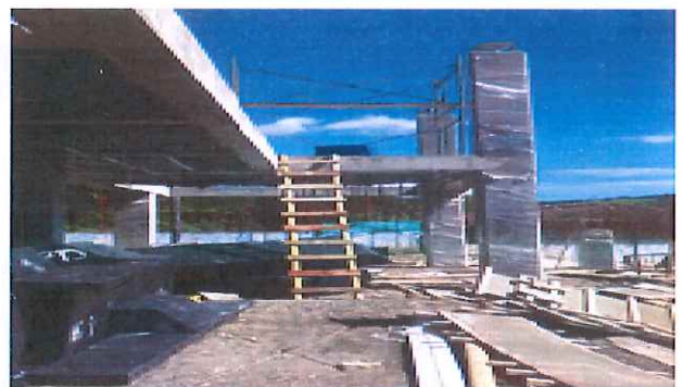
FOTO 6 FORRADO CON VINIPEL COLUMNAS 2 PISO
