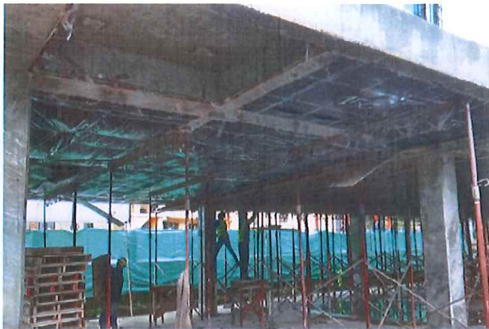
FOTO 4. DESENCOFRADO LOSA DE ENTREPISO
