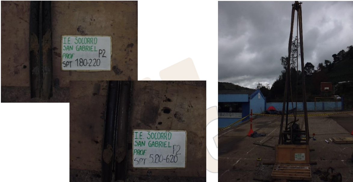
Fotografías 15 a 17. Exploraciones de campo y estratigrafía Perforación P-5
