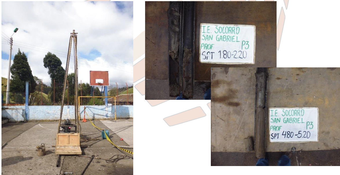
Fotografías 18 a 20. Exploraciones de campo y estratigrafía Perforación P-6
