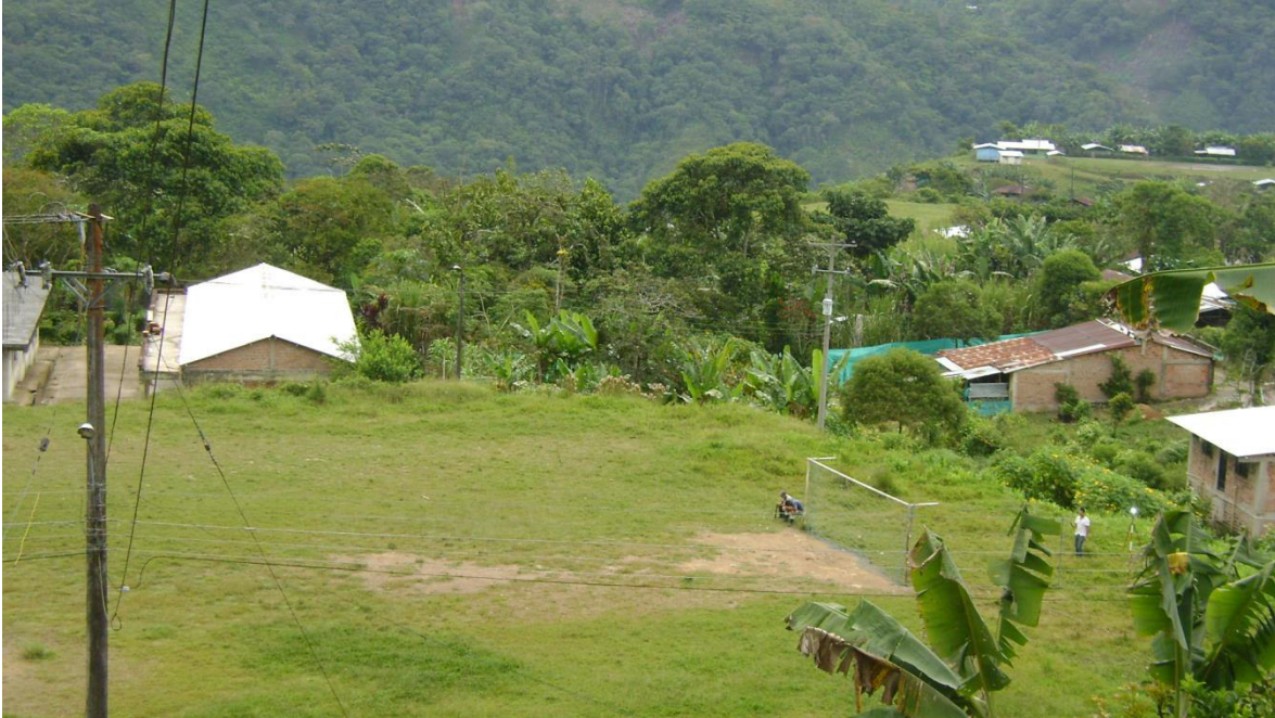
TRANSFORMADOR 15 KVA EN LA PARTE INFERIOR DE LA CANCHA.
