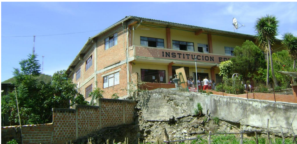
IMAGEN TOMADA DESDE LA PARETE EXTERNA DEL COLEGIO.
