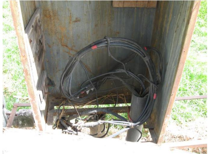
Fig. No 1.1.6 Caja de inspección y empalmes de acometida.
