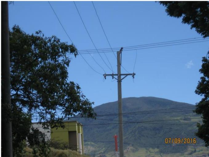
Fig. No 2.2 Derivación red de media tensión de CEDENAR hacia el transformador.
