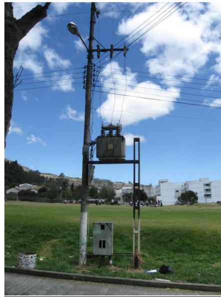
*Fig. No 1.1.1 Transformador propio de la institución.*
