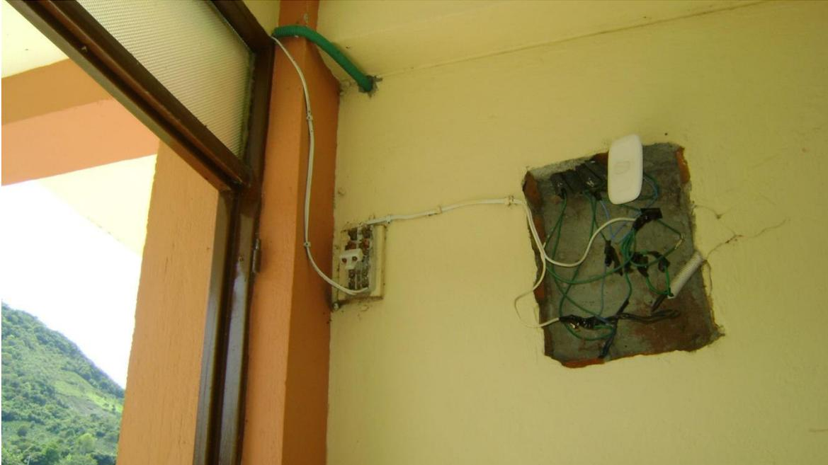
IMAGEN DE CIRCUITO PROTEGIDA CON CUCHILLA –SIN INSTALAR CAJA DE PASO.
