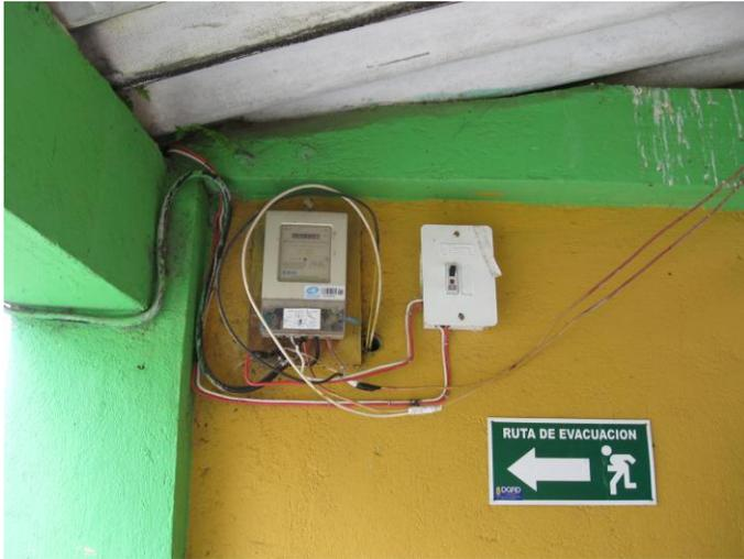
*Fig. No 1.1.3 Medidor y tablero de distribución.*
