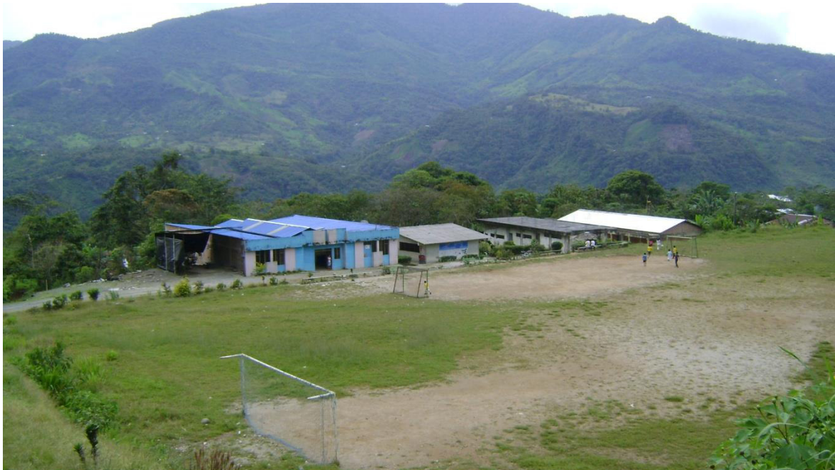
Imagen tomada desde la vía.
