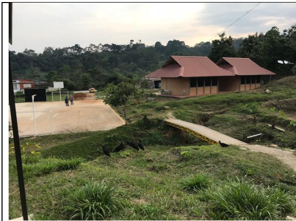
Fotografía 1. Estado actual Infraestructura Educativa.
