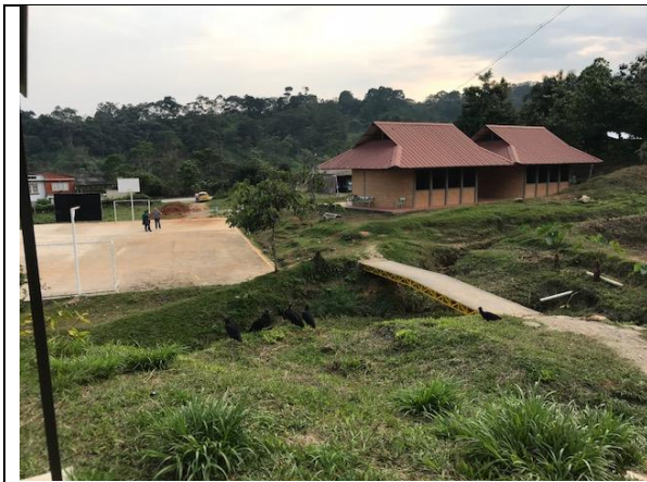
Fotografía 1. Estado actual Infraestructura Educativa.
