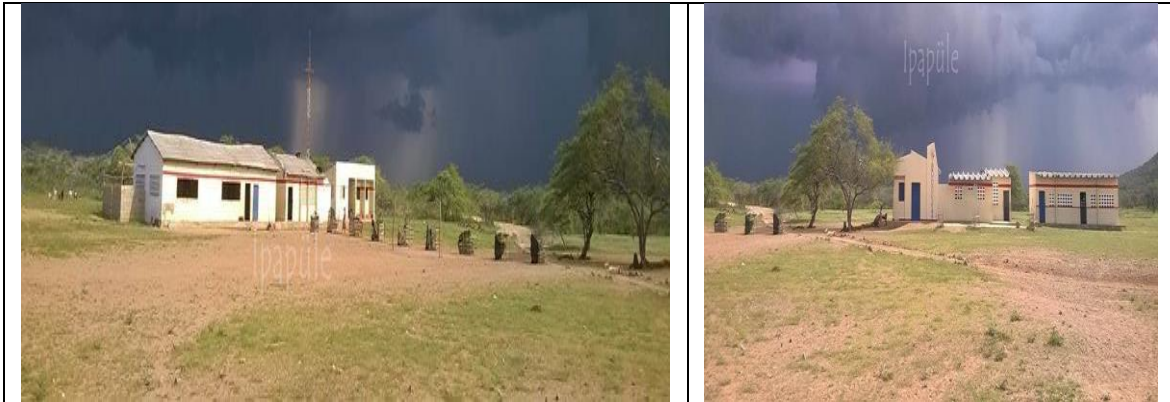
Fotografía 1. Estado actual Infraestructura Educativa.
