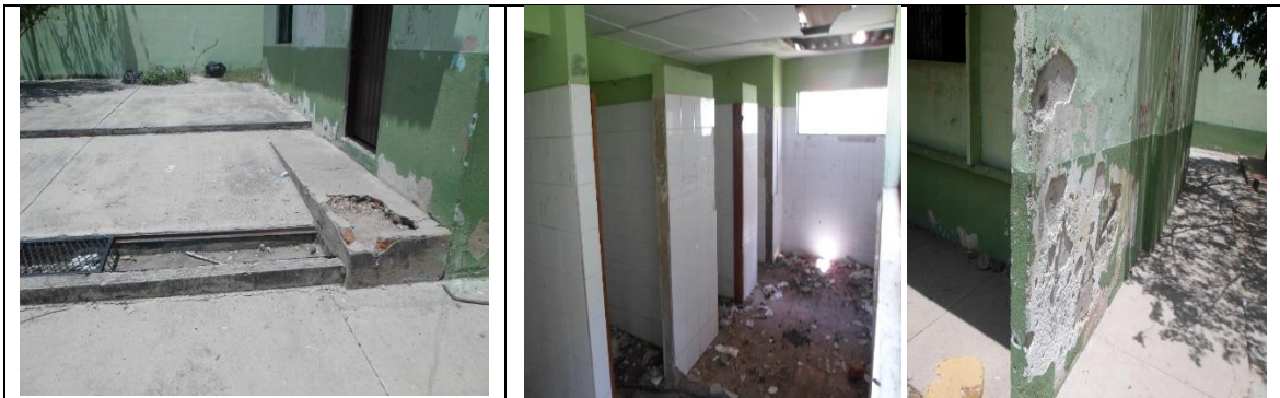
Fotografía 1. Estado actual Infraestructura Educativa.
