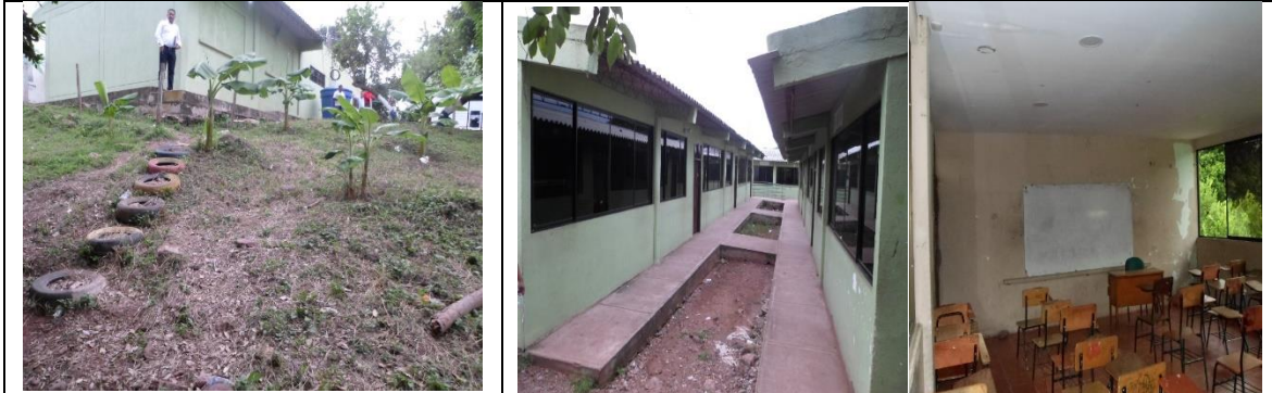
Fotografía 1. Estado actual Infraestructura Educativa.
