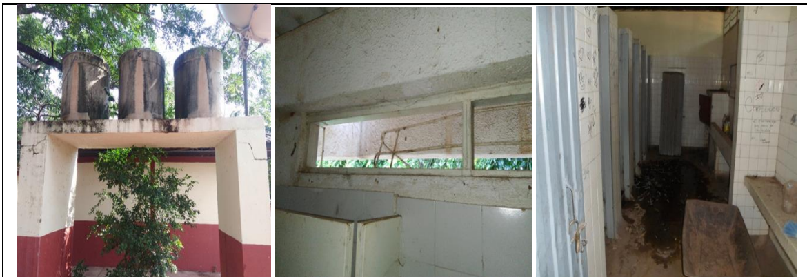
Fotografía 1. Estado actual Infraestructura Educativa.
