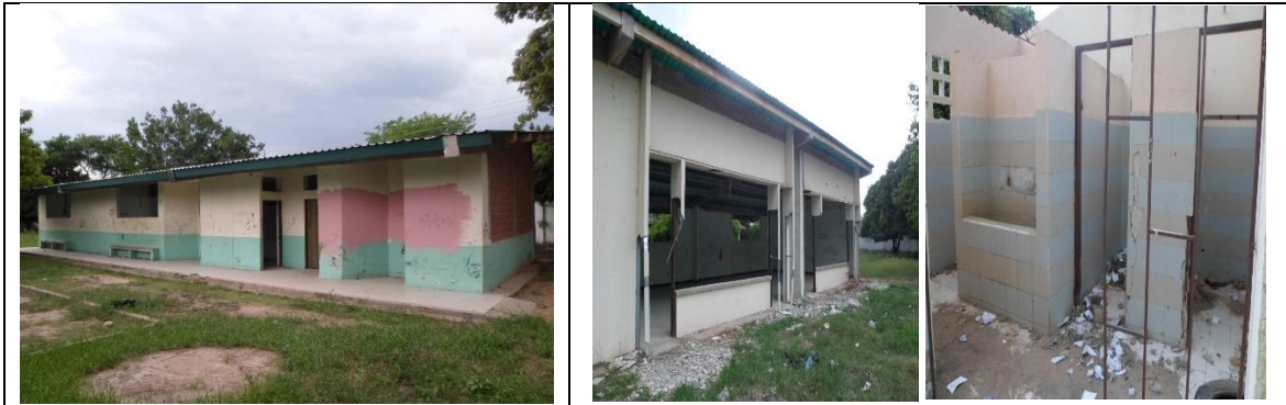
Fotografía 1. Estado actual Infraestructura Educativa.
