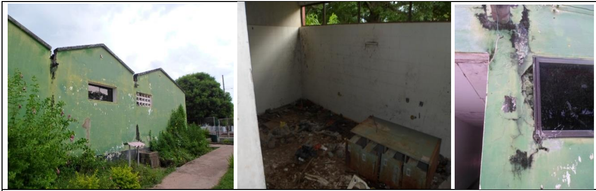
Fotografía 1. Estado actual Infraestructura Educativa.
