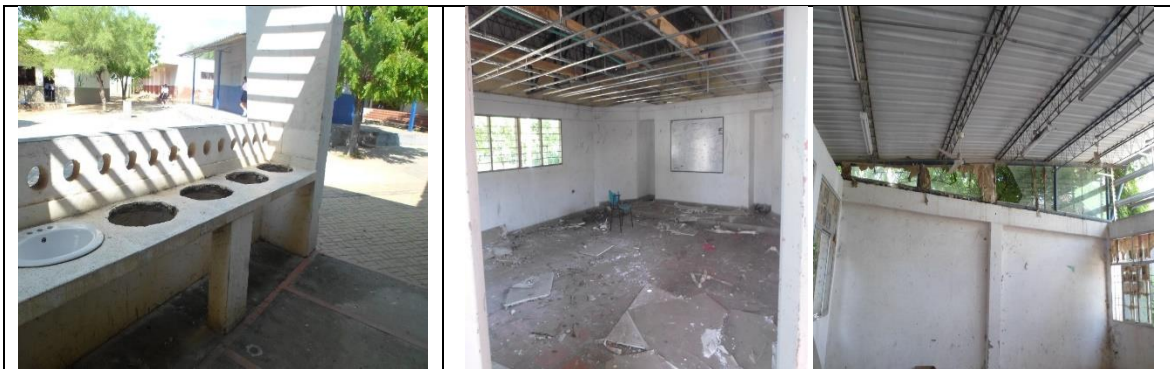
Fotografía 1. Estado actual Infraestructura Educativa.
