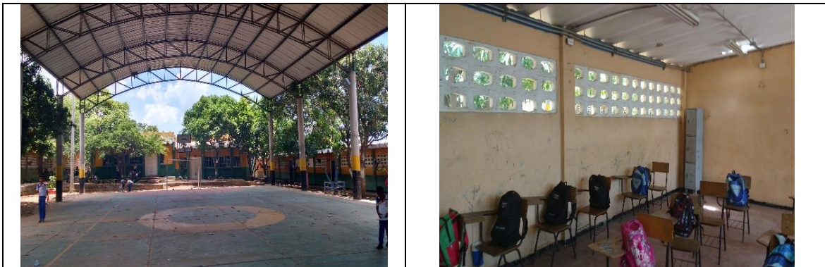
Fotografía 1. Estado actual Infraestructura Educativa.
