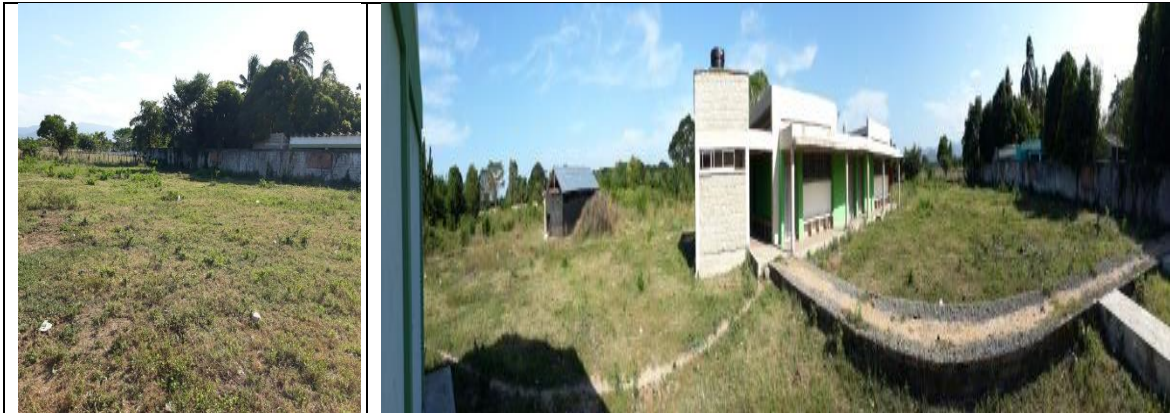
Fotografía 1. Estado actual Infraestructura Educativa.
