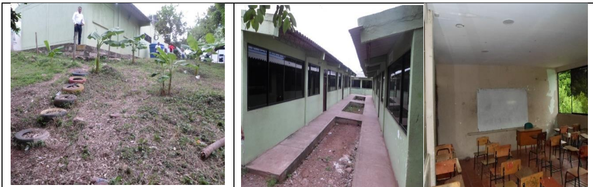
Fotografía 1. Estado actual Infraestructura Educativa.
