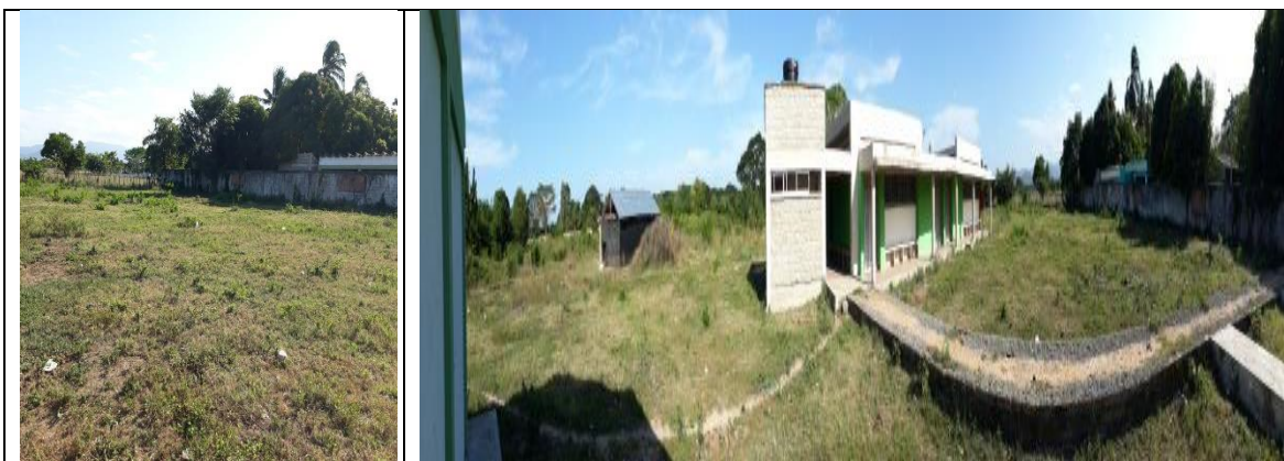
Fotografía 1. Estado actual Infraestructura Educativa.
