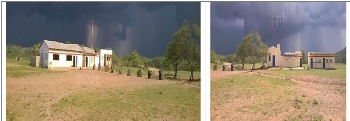
Fotografía 1. Estado actual Infraestructura Educativa.
