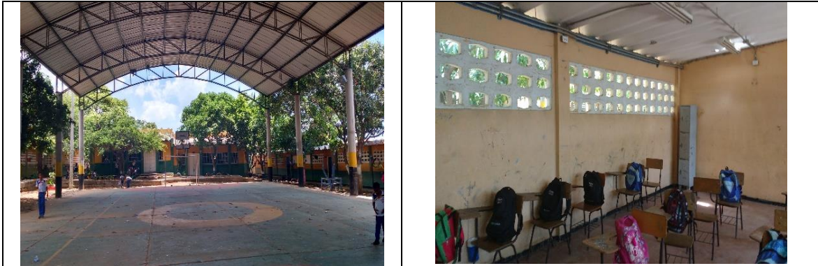
Fotografía 1. Estado actual Infraestructura Educativa.
