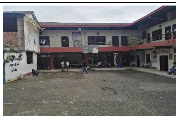
Fotografía 2. Estado actual Infraestructura Educativa
