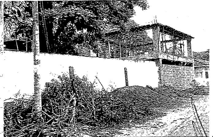
MURO EXTERIOR DE LA IE - MANEJO DE ESCOMBROS
