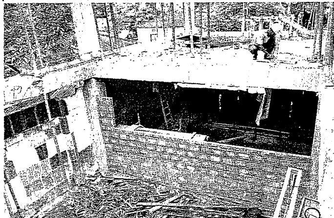
VACIO CENTRAL DE LA EDIFICACIÓN - VISTA DESDE LA ESCALERA
