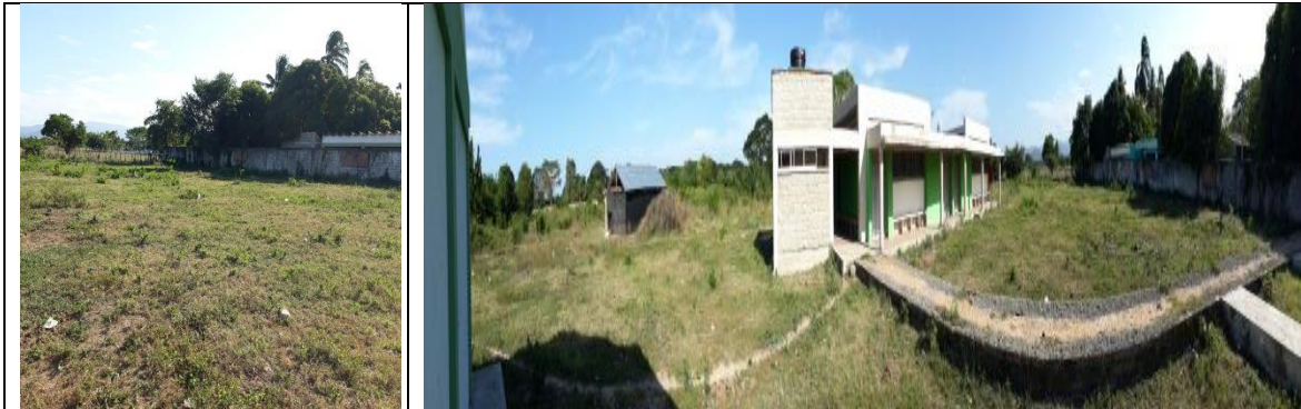
Fotografía 1. Estado actual Infraestructura Educativa.
