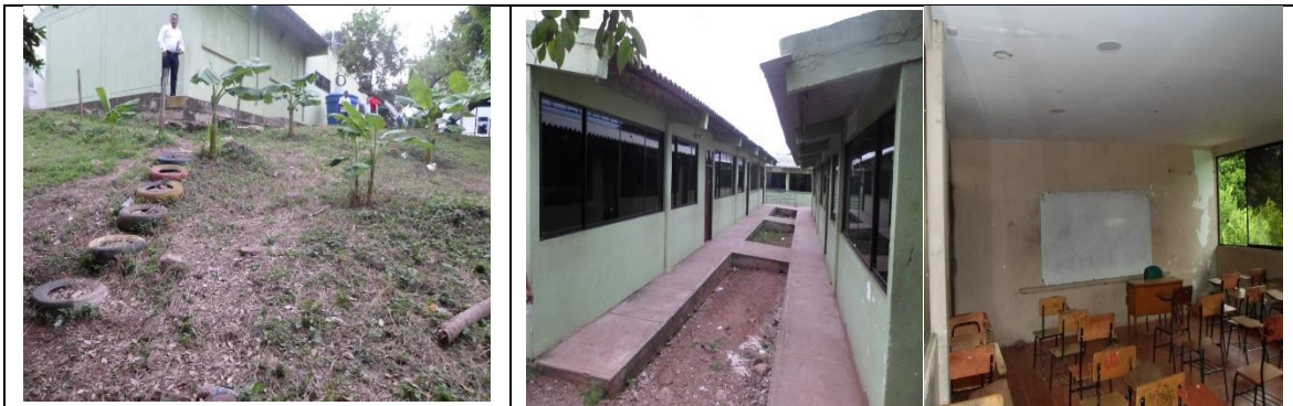
Fotografía 1. Estado actual Infraestructura Educativa.
