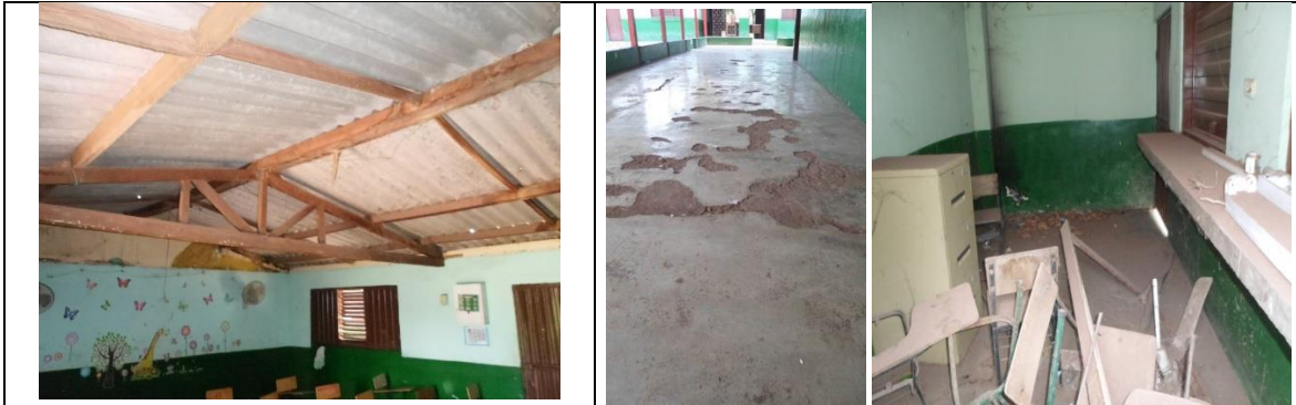
Fotografía 1. Estado actual Infraestructura Educativa
