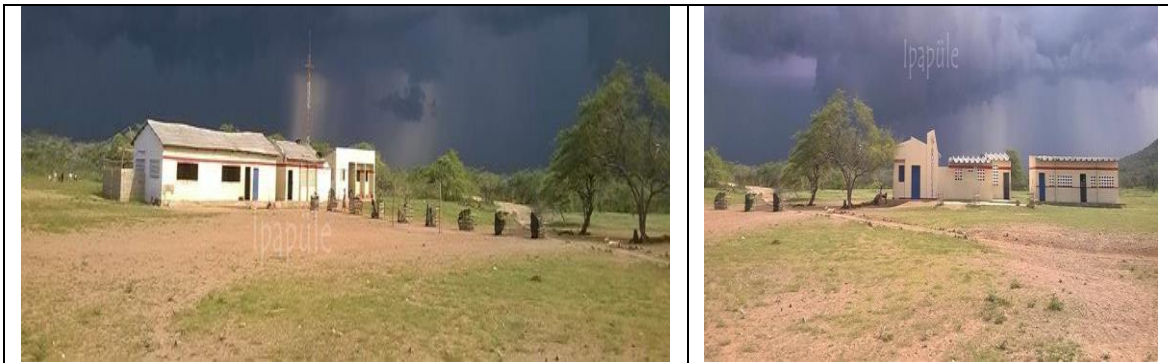
Fotografía 1. Estado actual Infraestructura Educativa.
