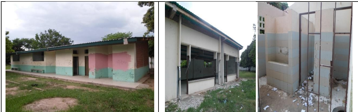
Fotografía 1. Estado actual Infraestructura Educativa.
