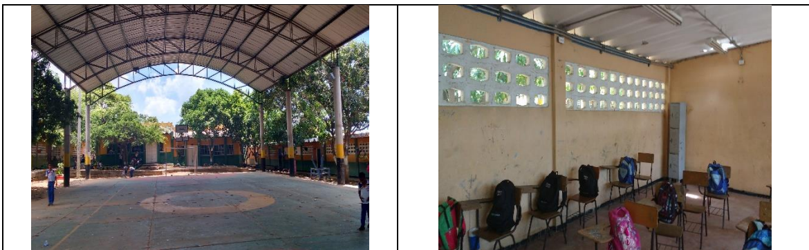
Fotografía 1. Estado actual Infraestructura Educativa.
