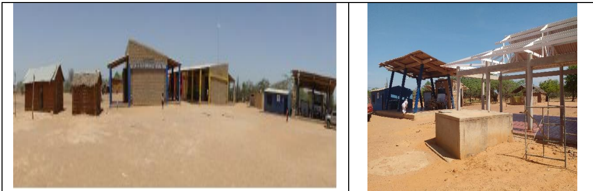
Fotografía 1. Estado actual Infraestructura Educativa.
