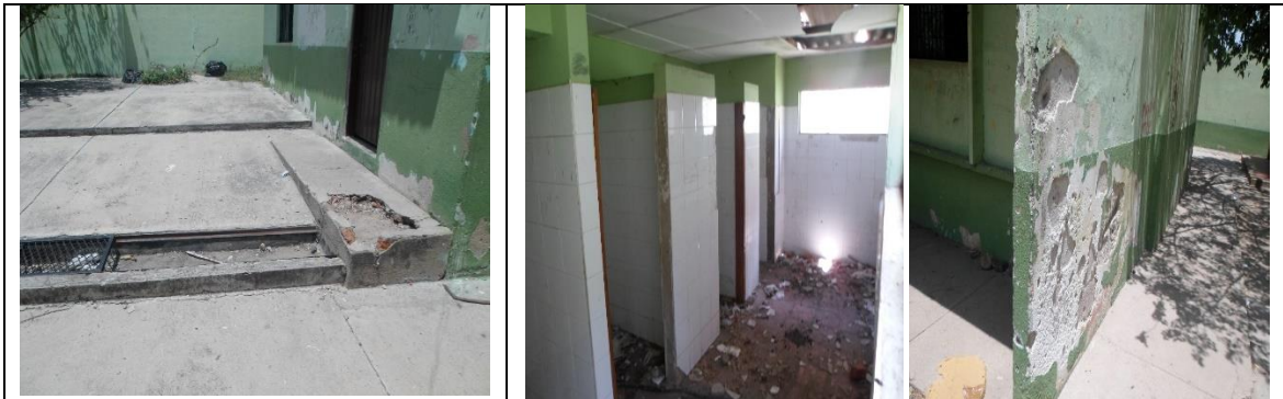
Fotografía 1. Estado actual Infraestructura Educativa.
