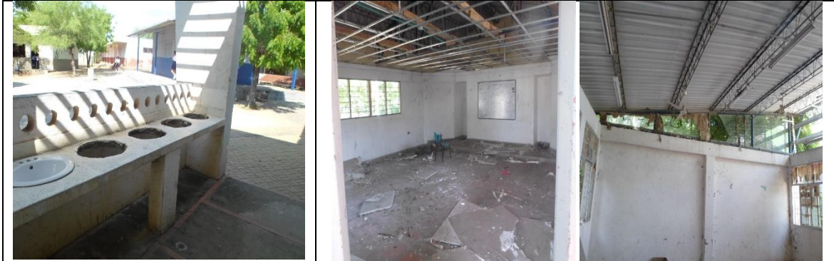
Fotografía 1. Estado actual Infraestructura Educativa.
