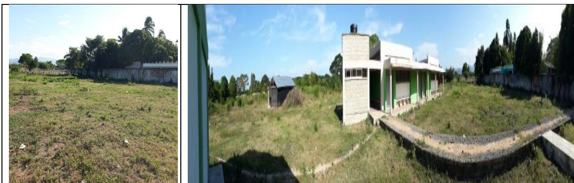
Fotografía 1. Estado actual Infraestructura Educativa.
