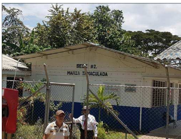
1Fotografía Estructura existente
