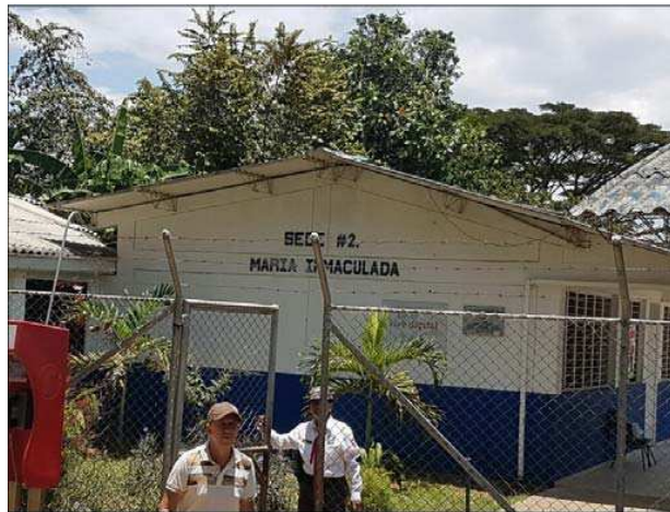
1Fotografía Estructura existente
