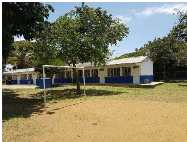
2Fotografía Estructura existente
