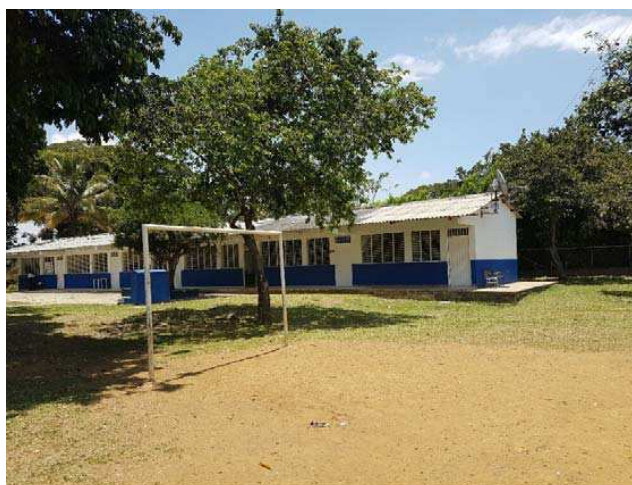
2Fotografía Estructura existente
