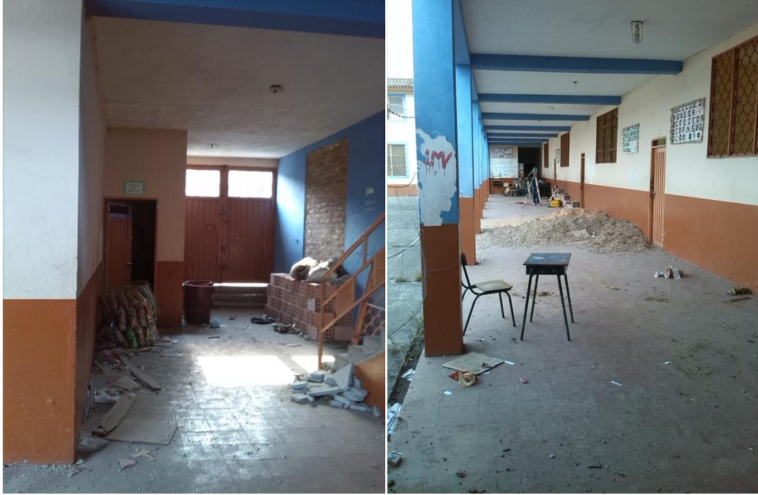
FOTO 9: Predio en demolición.
