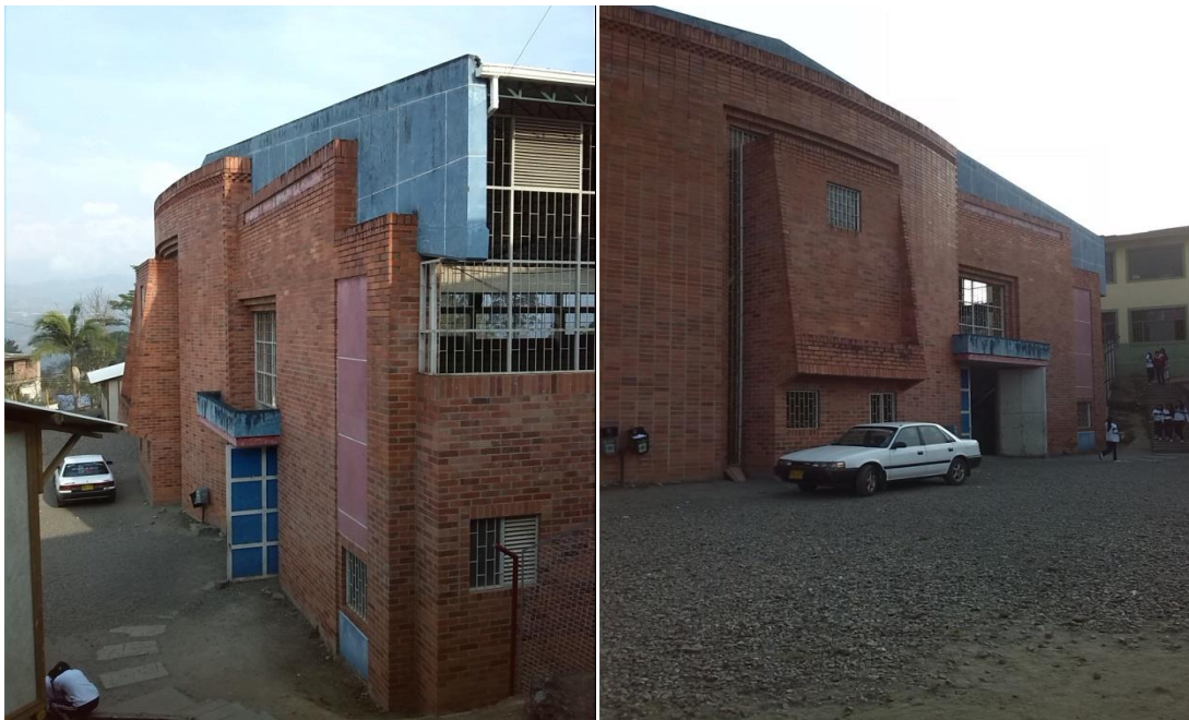
FOTO 10: Polideportivo estructura nueva.
