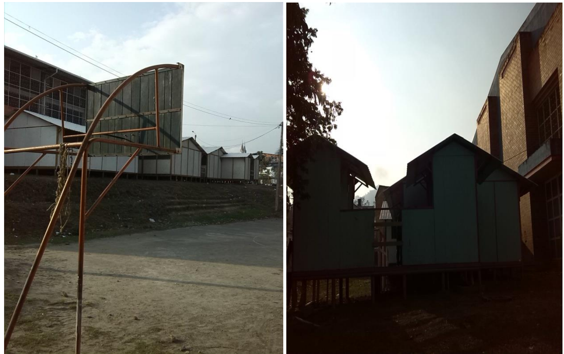
FOTO 8: Aulas de madera.
