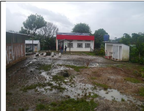
Fotografía 1. Estado actual Infraestructura Educativa.
