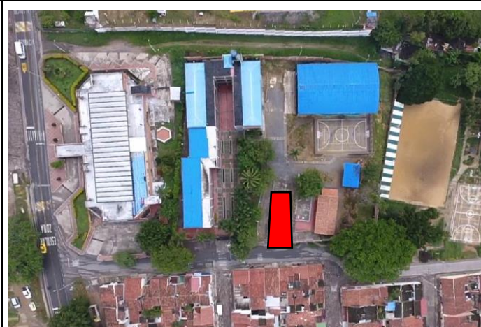
Fotografía 2. Área de intervención
