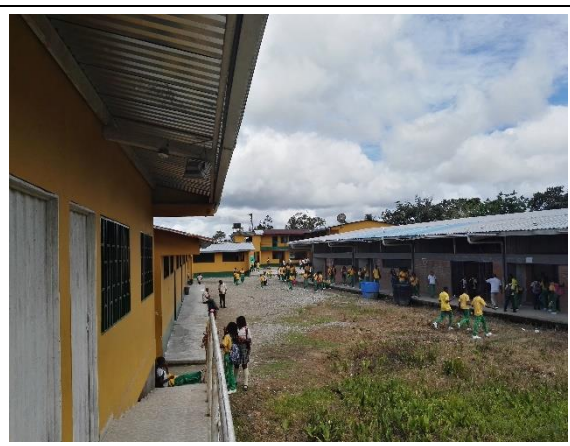
Fotografía 2. Estado actual Infraestructura Educativa
