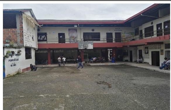
Fotografía 2. Estado actual Infraestructura Educativa
