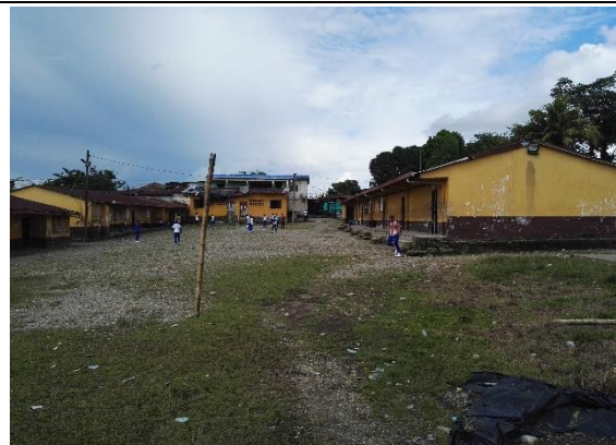
Fotografía 2. Estado actual Infraestructura Educativa
