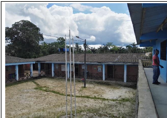
Fotografía 1. Estado actual Infraestructura Educativa.
