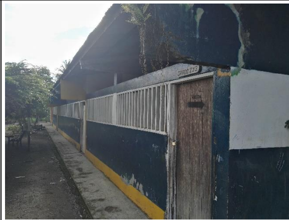
Fotografía 2. Estado actual Infraestructura Educativa
