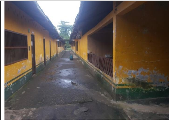
Fotografía 1. Estado actual Infraestructura Educativa.
