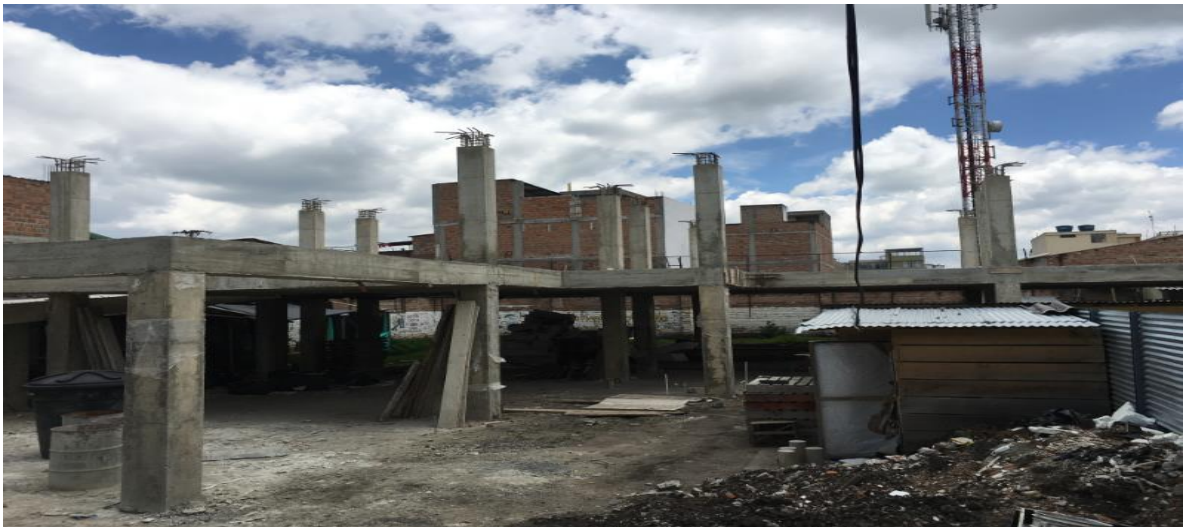
PANORAMICA ESTADO ACTUAL OBRA
