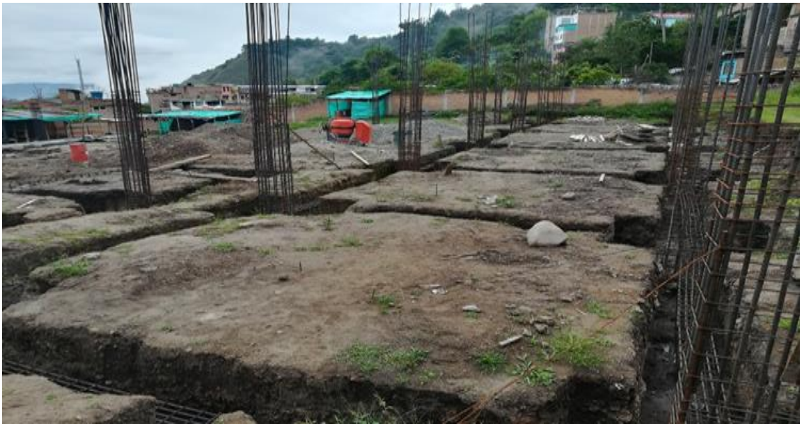
PANORAMICA ESTADO ACTUAL OBRA
