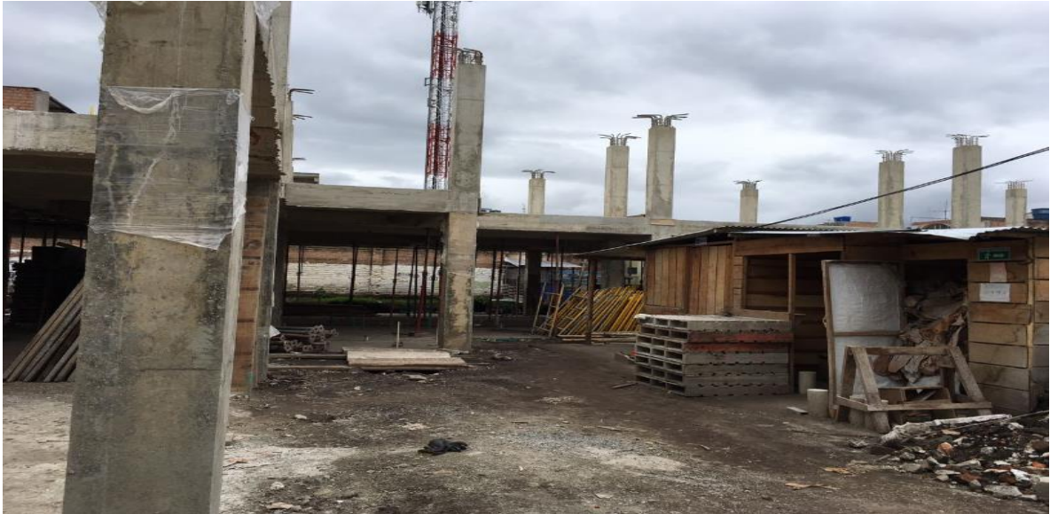
PANORAMICA ESTADO ACTUAL OBRA
