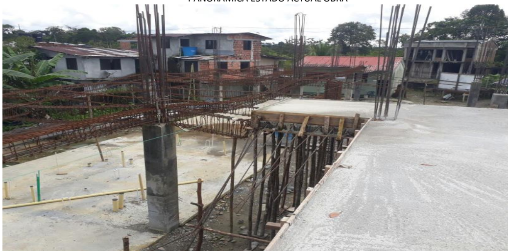
PANORAMICA ESTADO ACTUAL OBRA
