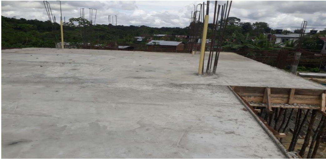
PANORAMICA ESTADO ACTUAL OBRA
