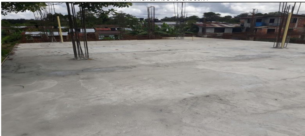
PANORAMICA ESTADO ACTUAL OBRA
