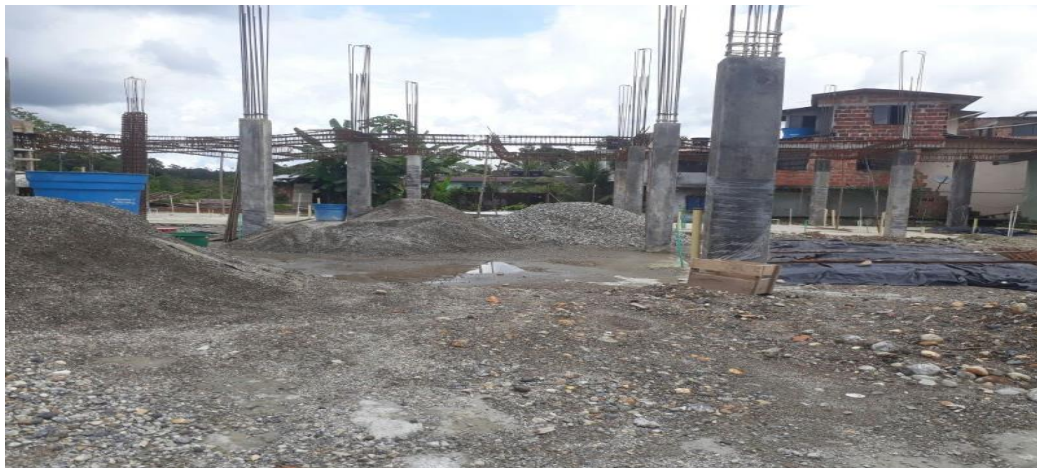
PANORAMICA ESTADO ACTUAL OBRA
