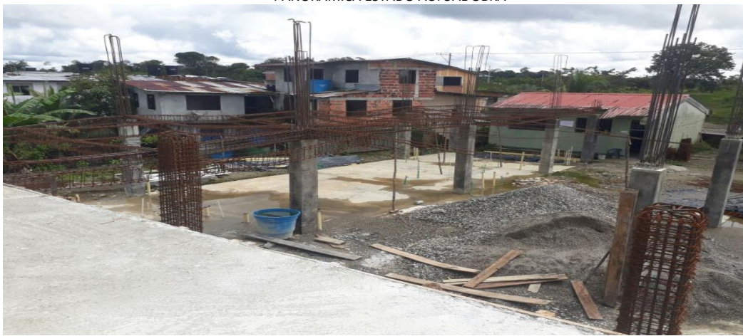
PANORAMICA ESTADO ACTUAL OBRA
