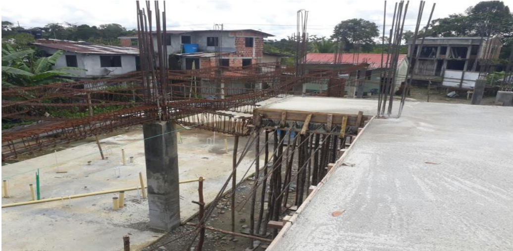
PANORAMICA ESTADO ACTUAL OBRA
