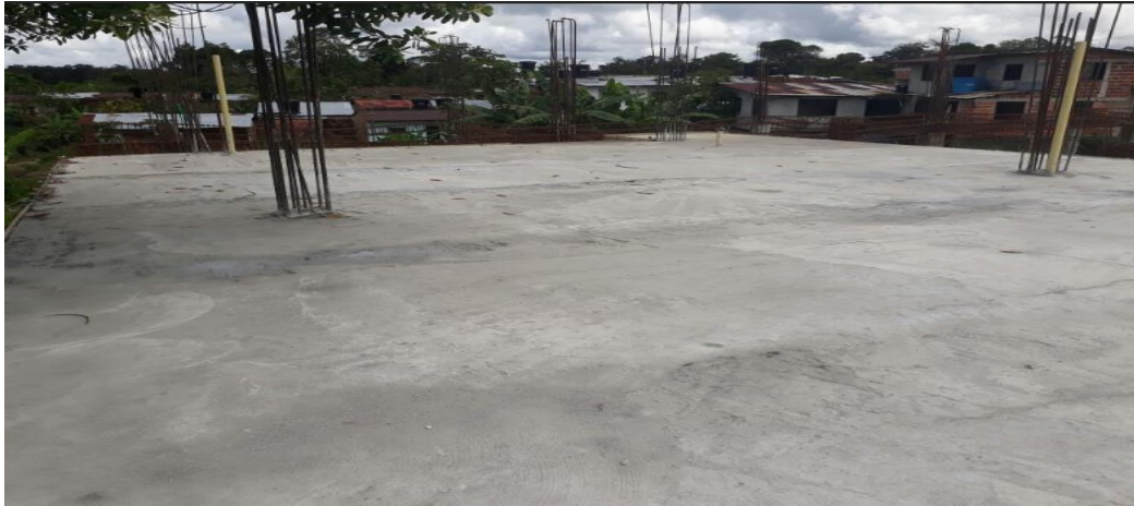
PANORAMICA ESTADO ACTUAL OBRA
