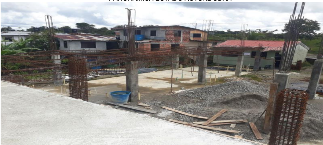
PANORAMICA ESTADO ACTUAL OBRA
