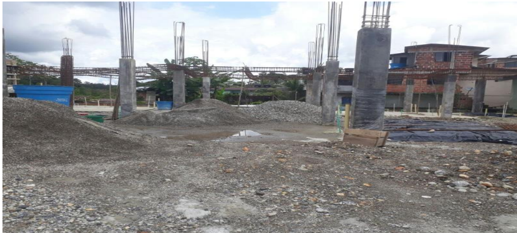
PANORAMICA ESTADO ACTUAL OBRA
