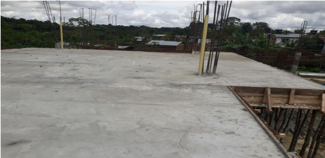
PANORAMICA ESTADO ACTUAL OBRA
