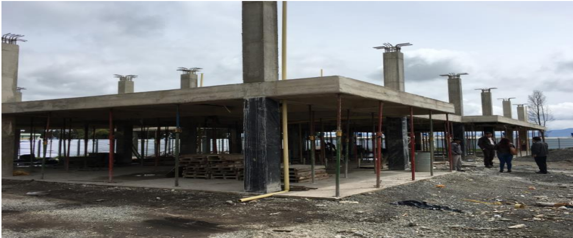
PANORAMICA ESTADO ACTUAL OBRA
