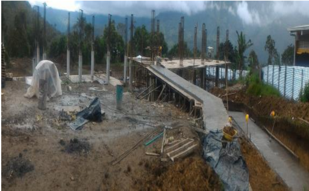
PANORAMICA ESTADO ACTUAL OBRA
