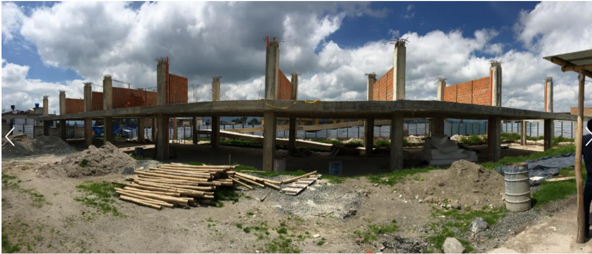
PANORAMICA ESTADO ACTUAL OBRA
