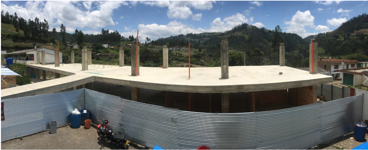
PANORAMICA ESTADO ACTUAL OBRA
