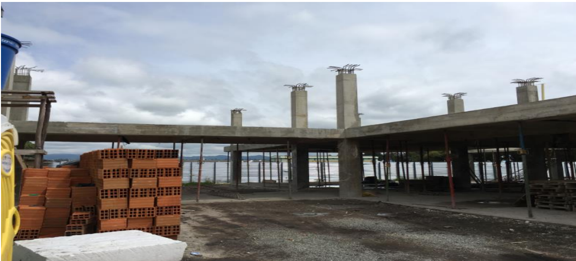
PANORAMICA ESTADO ACTUAL OBRA
