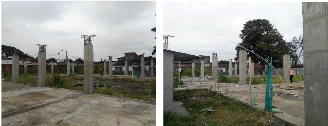
PANORAMICA ESTADO ACTUAL DE LA OBRA
