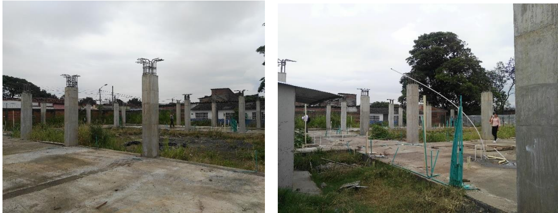
PANORAMICA ESTADO ACTUAL DE LA OBRA
