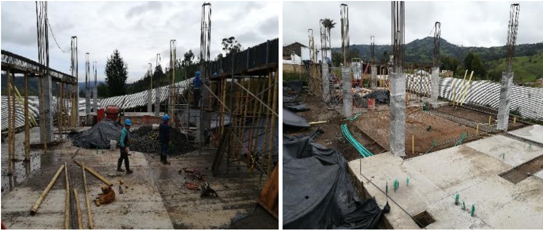
PANORAMICA ESTADO ACTUAL OBRA
