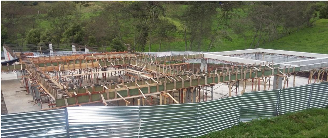
ESTADO ACTUAL OBRA
