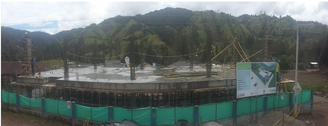
ESTADO ACTUAL OBRA
