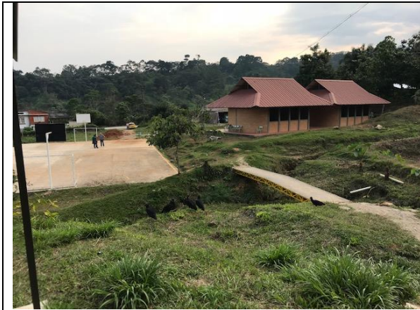
Fotografía 1. Estado actual Infraestructura Educativa.
