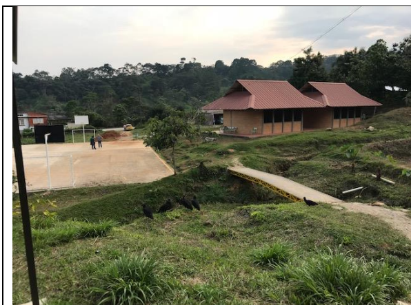
Fotografía 1. Estado actual Infraestructura Educativa.
